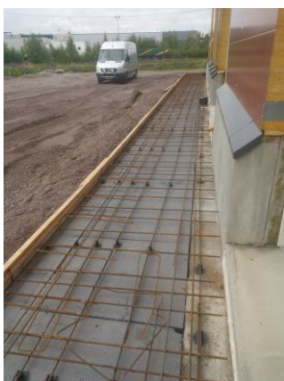
Kuva 14. Ulkopuolisen betonilaatan rauditus
