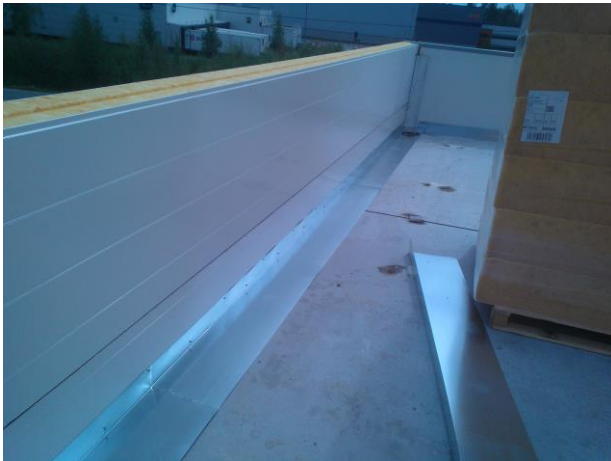
Kuva 10. Pelti- ja listojen asennus saumoihin
