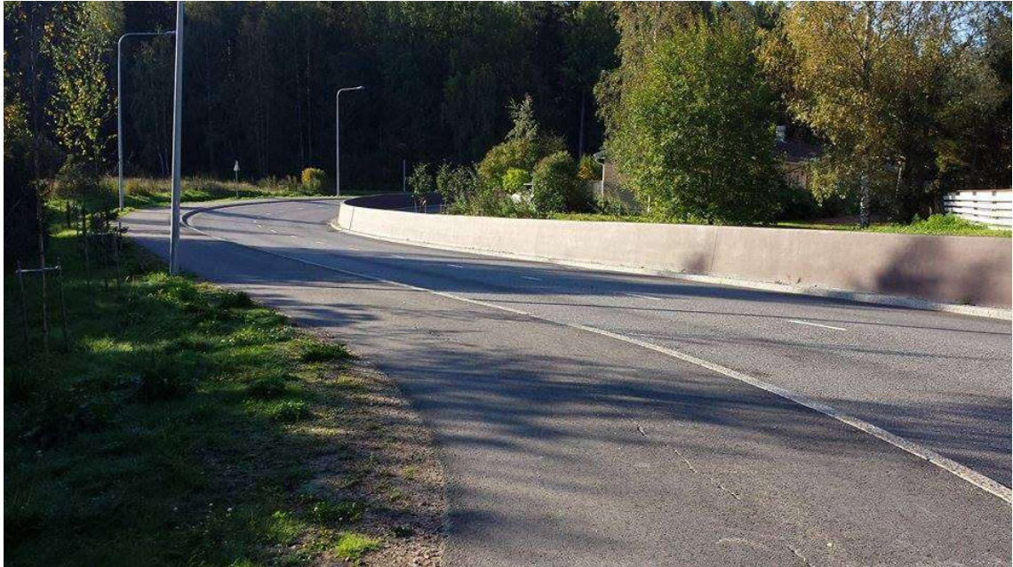
Kuva 7. Sunankaari, Espoo, liukuvalettu melu- ja törmäyskaide
