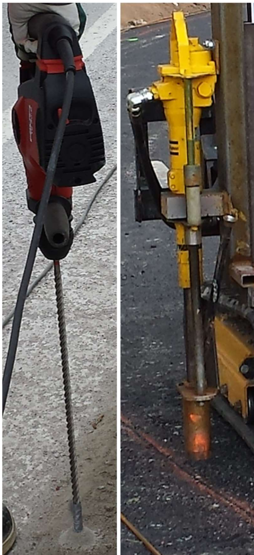
Kuva 18. Pystyraudoituksen asennus
