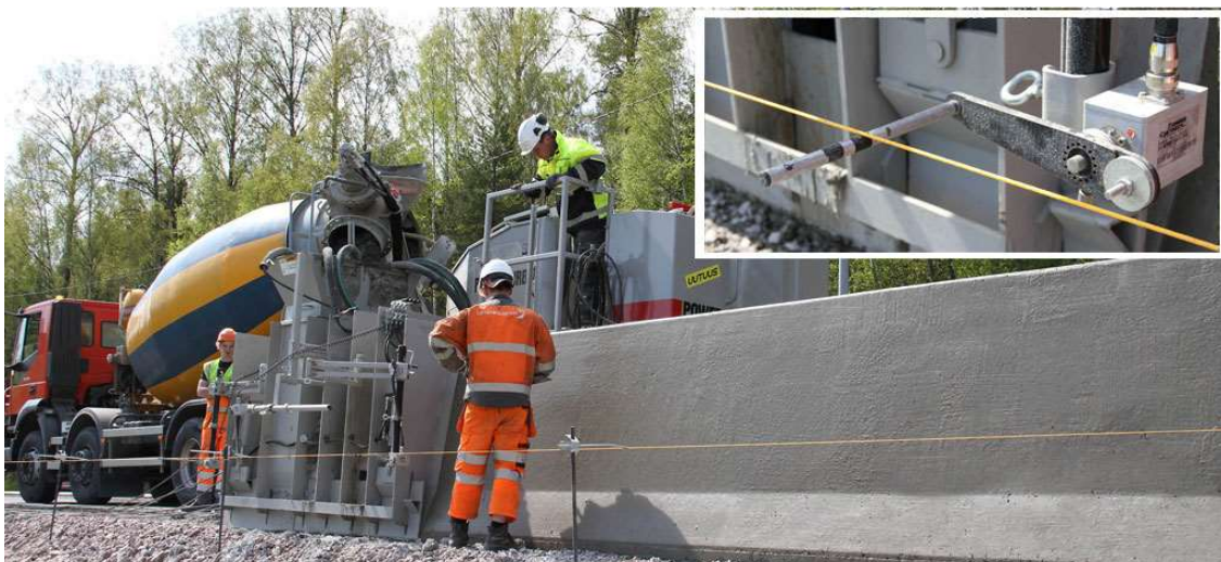
Kuva 22. Lemminkäinen infra, Kehä III, äänimuurin valu (1)
