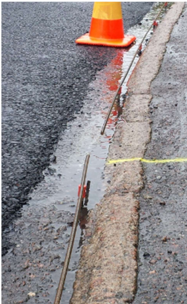
Kuva 19. Liikuntasauma väli raudoituksessa
