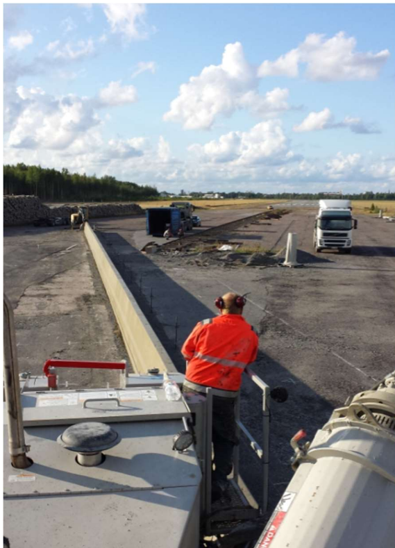
Kuva 12. Lemminkäinen infran liukuvalukaiteen valu törmäyskoetta varten, 2013
