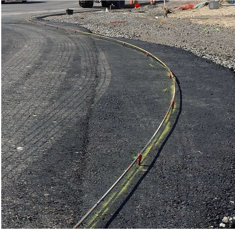
Kuva 11. Raudoitus, Käyrälammen työmaa 2013
