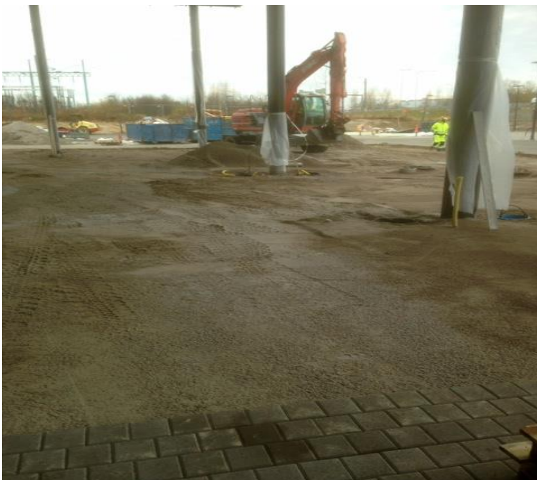
Kuva 5. Pohjatöitä Jatke Oy:n työmaalla Vantaalla.
