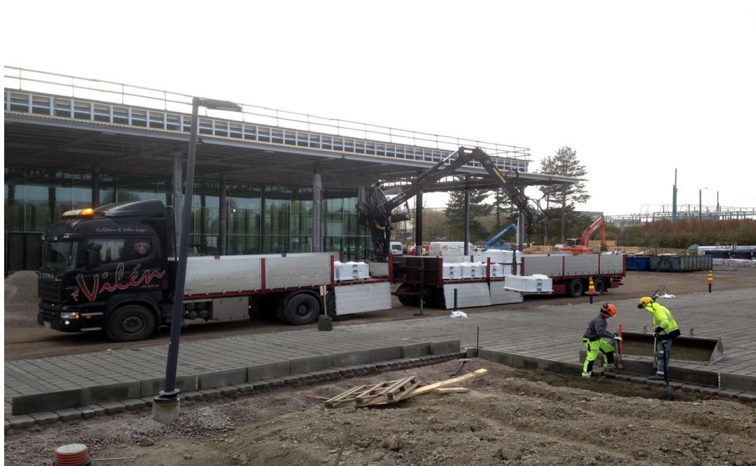
Kuva 4. Täysperävaunurekka tuo kerralla 38 tonnia betonikiveä.
