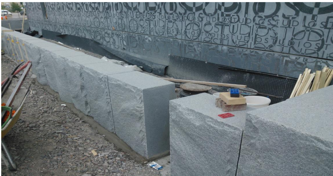
Kuva 2. Massiivinen tukimuri istutuksille.
