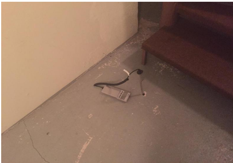
Kuva 4. Rakennekosteusmittaus kaksoisvalulaatan eristetilasta.
