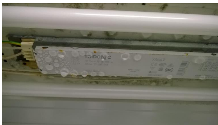
Kuva 9 Kosteutta loisteputkivalaisimessa
