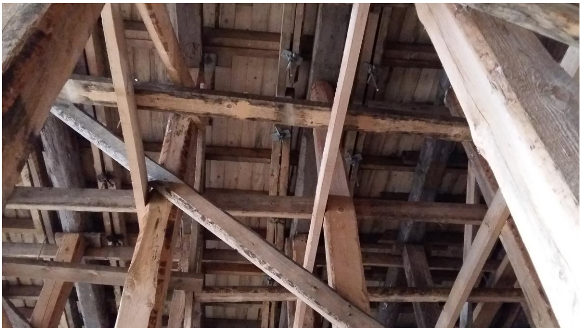
Kuva 29. Muottilukkoja ja sidejuoksuja kiinnitettynä paikoilleen
