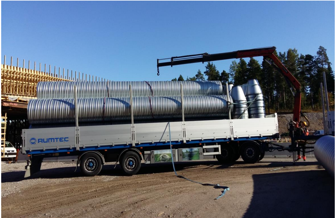
Kuva 17. Kevennyspotkikuorman purkamista työmaalla 31.8.2015
