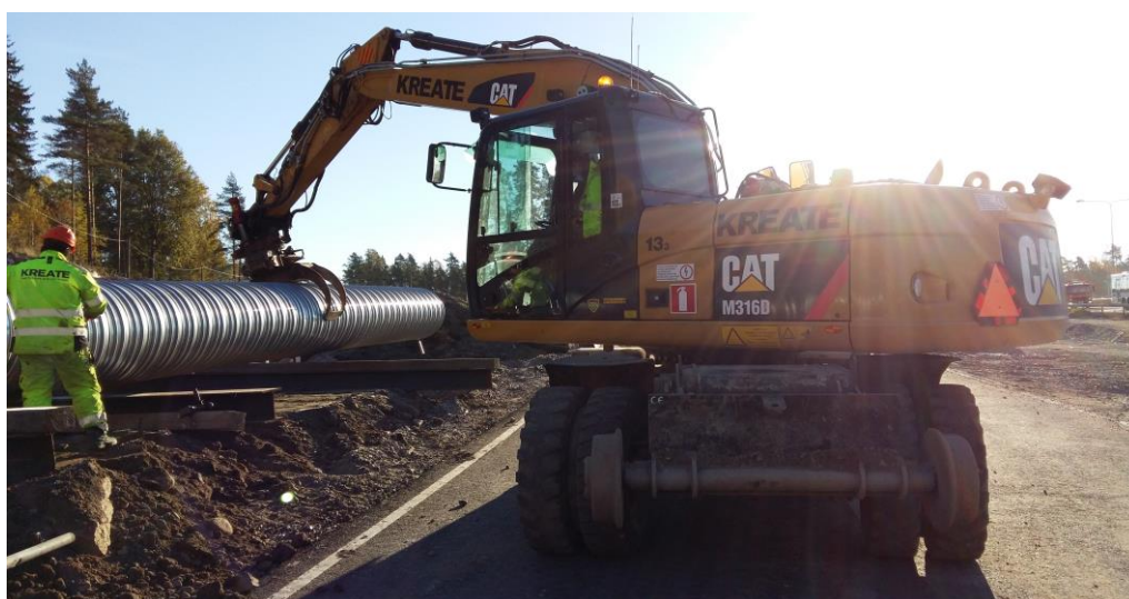
Kuva 15. Kreate Oy:n Caterpillar M316D-pyöräalustainen kaivinkone varustettuna kouralla
