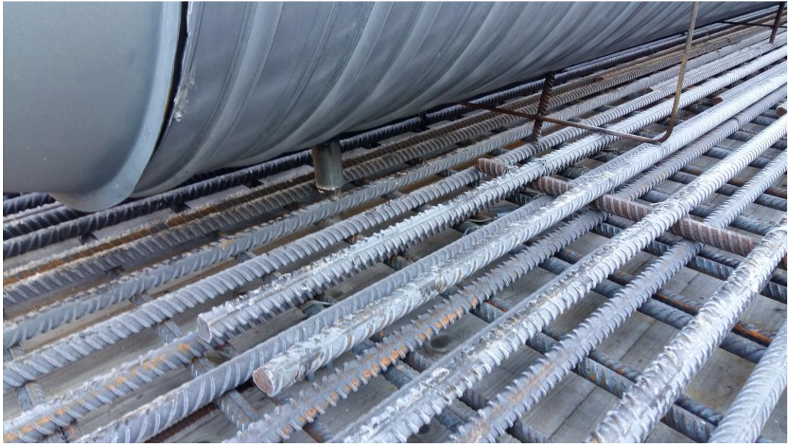
Kuva 32. Suora tuuletusputki asennettuna paikoilleen
