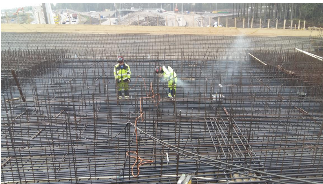
Kuva 23. Kannatusteräksen hitsaamista paikoilleen
