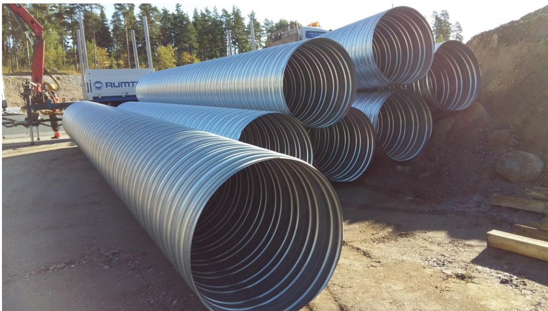
Kuva 8. TR1000ZN 1 000 g 1,5 mm:n kevennysputkia työmaalla
