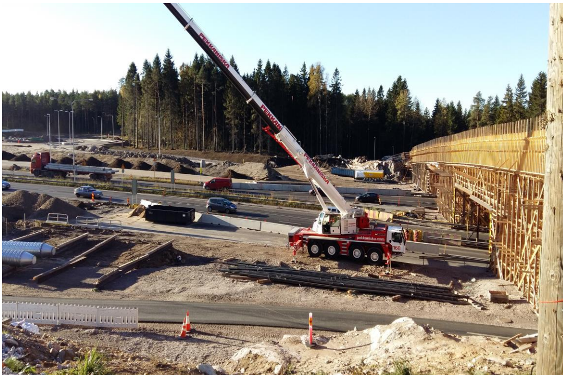
Kuva 16. Kevennysputkien nostoon käytetty Liebherr LTM 1070-4.1 mobiilinosturi
