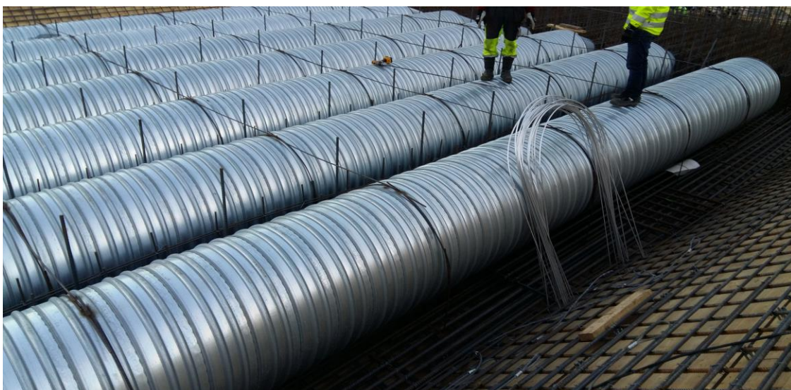
Kuva 27. Sivusiteitä hitsattuna paikoilleen
