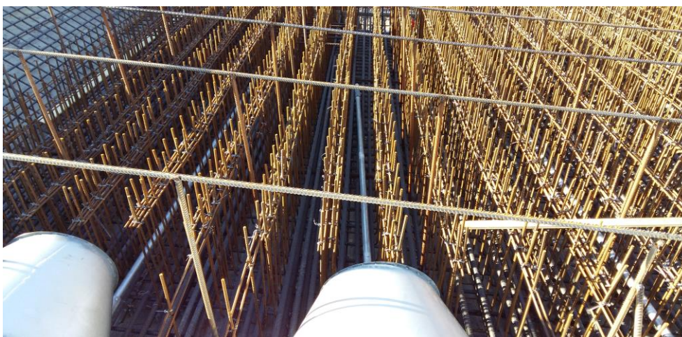
Kuva 31. Sillan kannella jatkettuja tuuletusputkia
