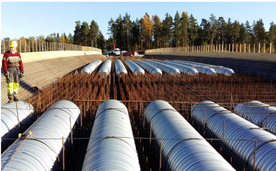
Kuva 26. Tukivälillä T1–T2 ja T2–T3 kevennysputkia asennettuna paikoilleen
