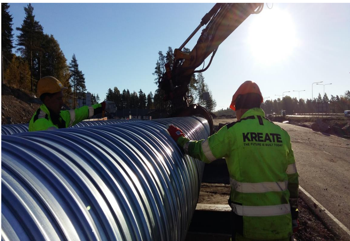
Kuva 20. Kevennysputkien jatkamista työmaalla
