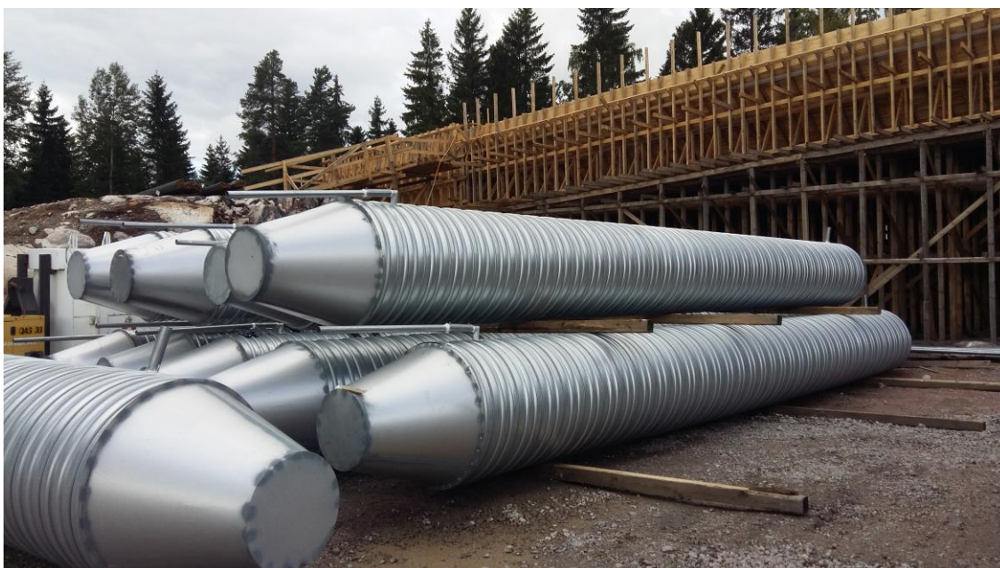
Kuva 19. Valmiita 10-metrisiä kevennysputkia siltatelineen vieressä
