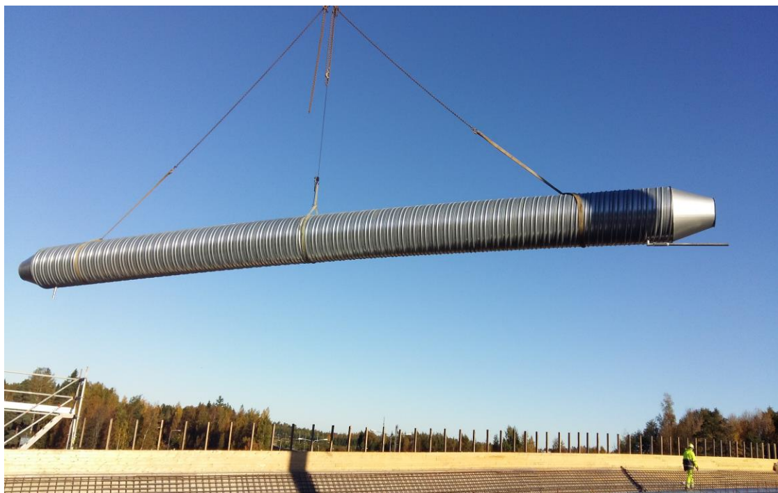
Kuva 25. 16-metrinen kevennysputken nosto
