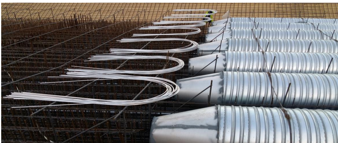
Kuva 28. Kevennysputkien sidontaan käytettäviä alumiinisiteitä
