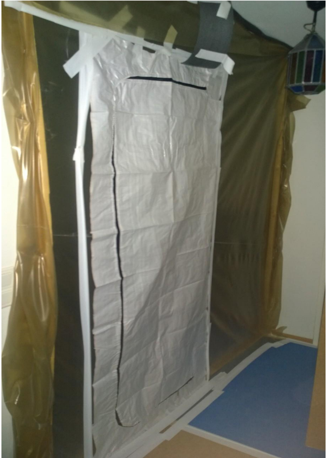
Kuva 4. Asuntoon tehtävä suojaseinä.
