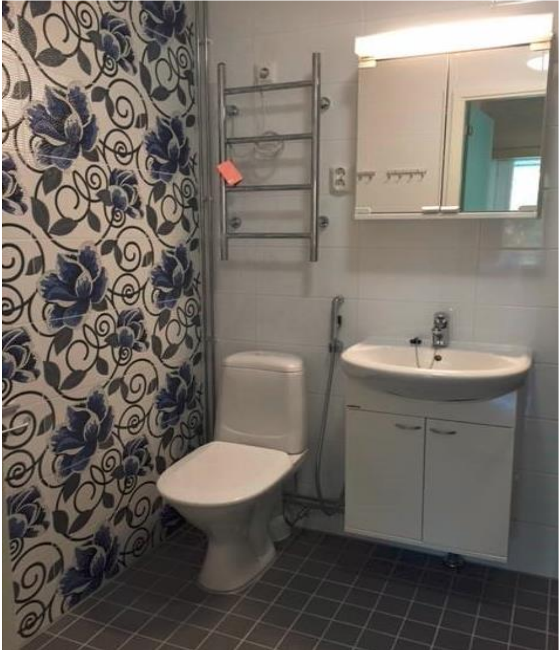
Kuva 6. Tilanne kylpyhuoneessa itselluovutuksen jälkeen.
