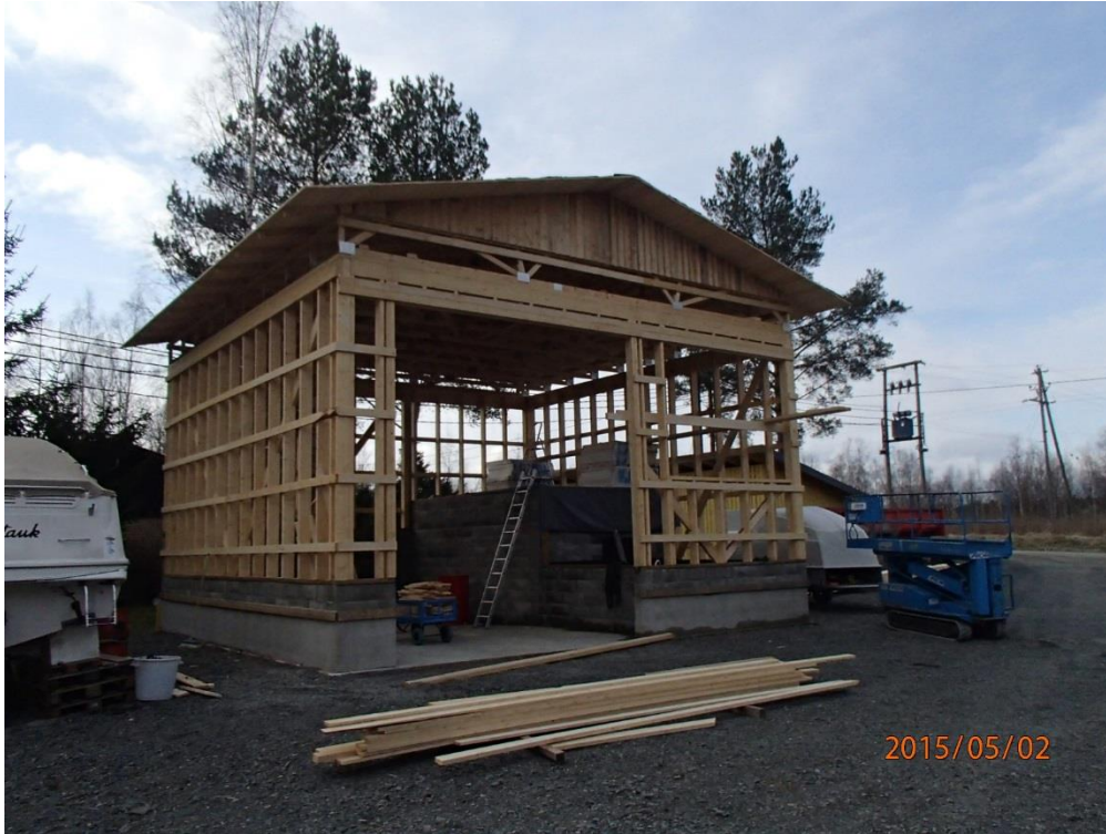
Kuva 2. Runko ja kattotuolit asennettuna. (Reinola 2015)
