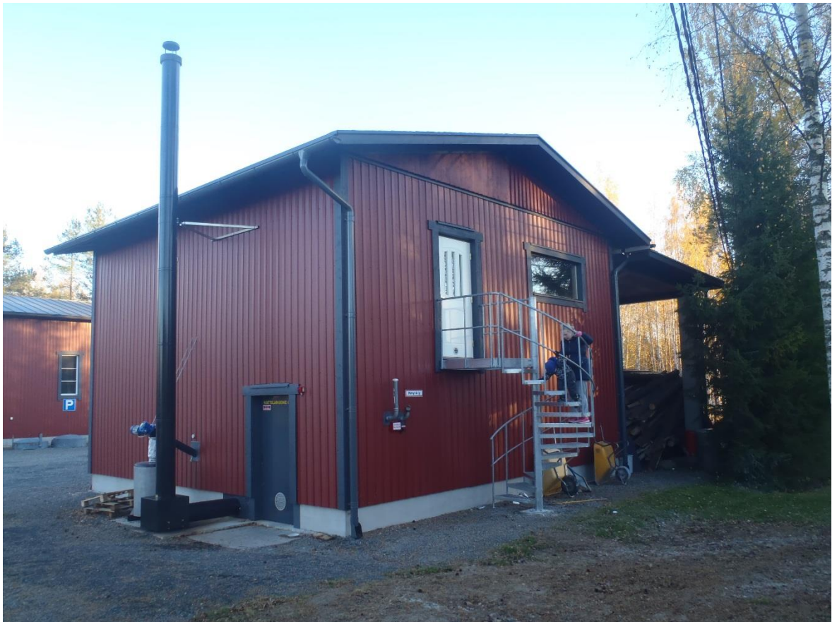
Kuva 25. Savupiippu ja kierreportaat kattilahuoneen päällä olevaan huoneeseen (Reinola 2015)
