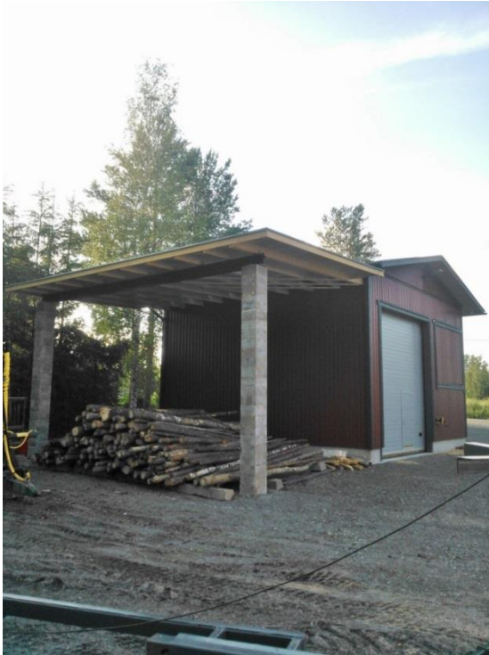
Kuva 7. Rankakatos ja lämpölaitos. (Reinola 2015)
