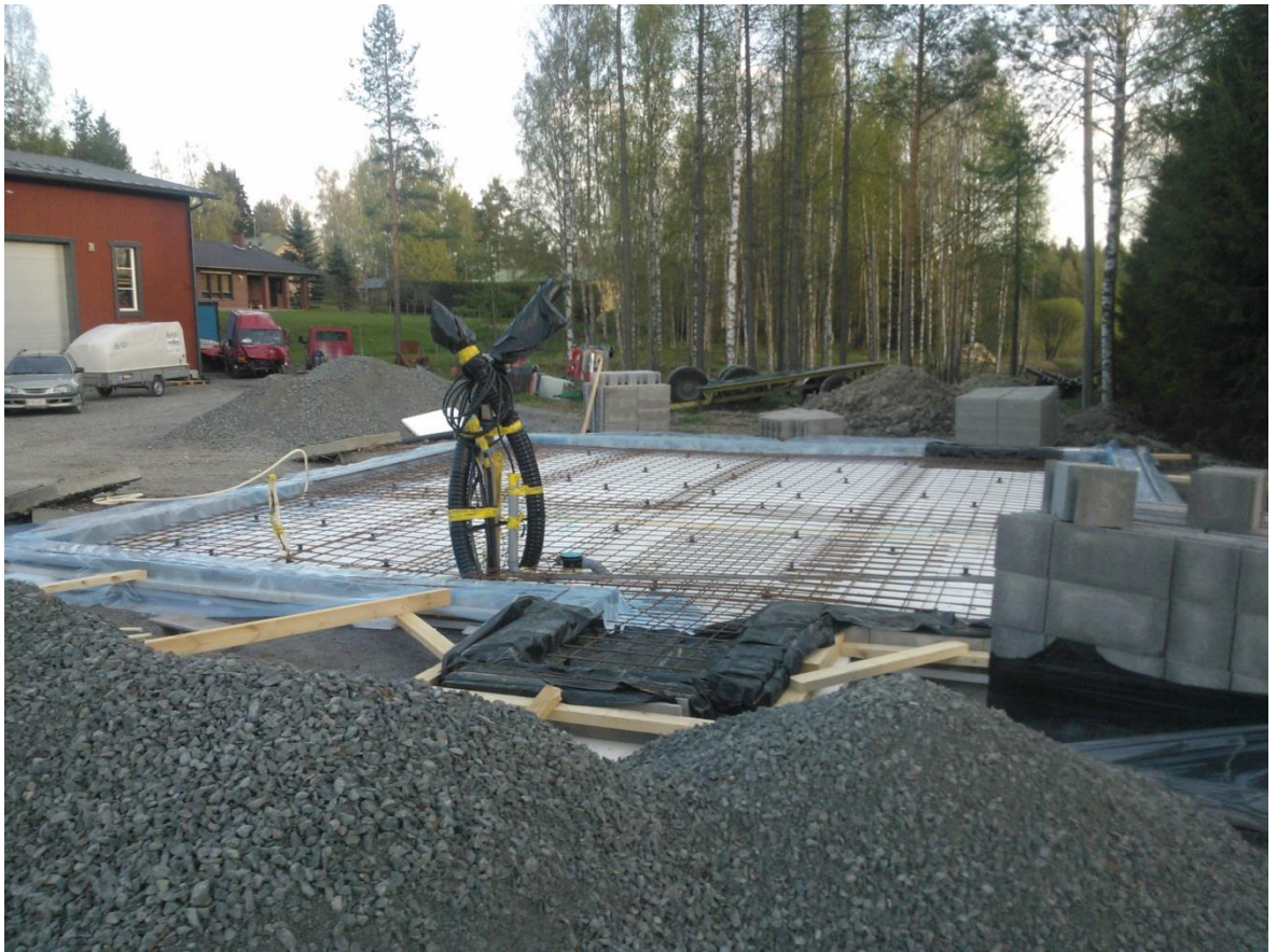
Kuva 4. Lämpölaitoksen pohja ennen valua (Reinola 2014)
