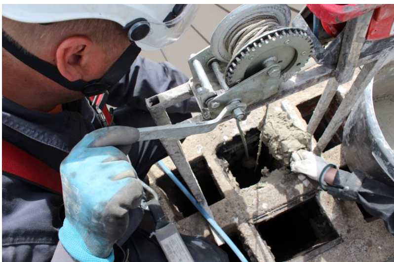
Kuva 13 Hormin massaaminen meneillään. [14]
