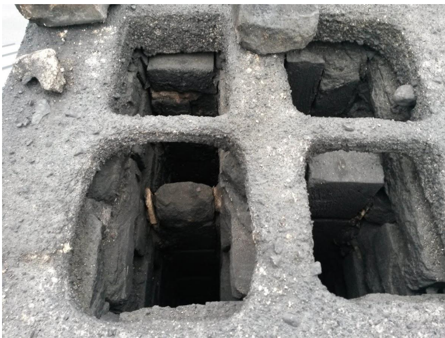
Kuva 1 Erittäin huonoon kuntoon rapautunut piipun yläpää. [14]
