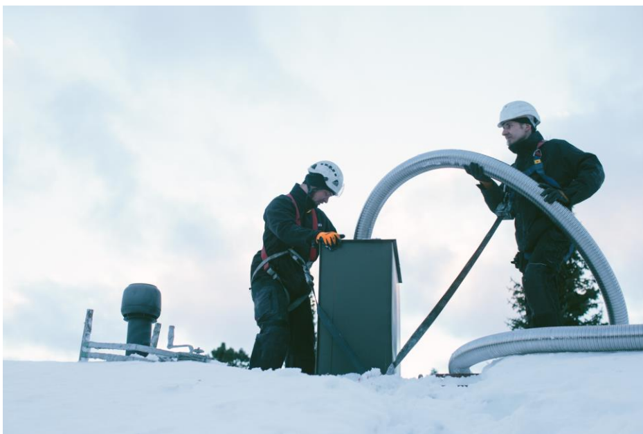
Kuva 11 Putken sujuttamista hormiin. [17]
