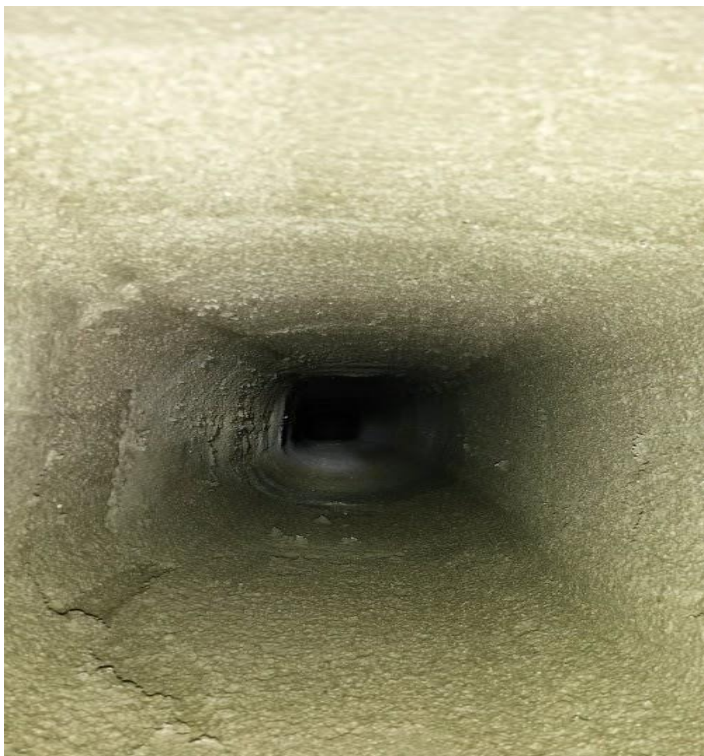
Kuva 14 Massatun hormin sisäpinta. [14]
