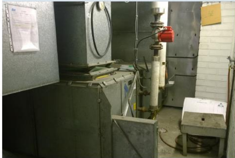
Kuva 7. Toimisto-osan tuloilmankone
