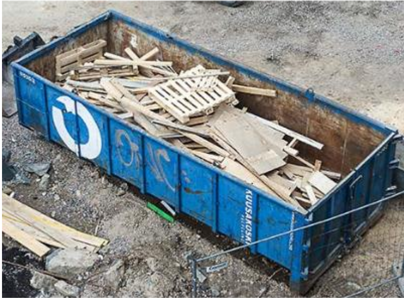
Kuva 7. Puujätteen kierrätystä rakennustyömaalla [12, s. 6].
