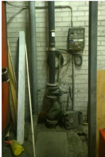
Kuva 10. Eteläpään työnjohtotoimiston pumppaamon purku. Näkyvät osat ovat purettu sisustuspurkuvaiheessa.
