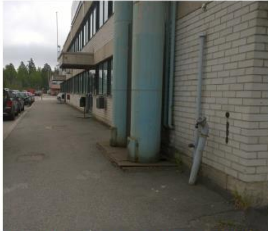
Kuva 1. Vanhat savupiiput ja öljysäiliön täyttö- ja ilmajohto, purku LVIA-urakassa.
