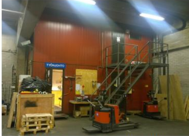
Kuva 11. Rakennuksen eteläpäähän myöhemmin rakennettu työnjohtotoimisto.
