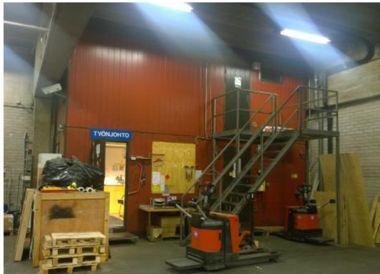
Kuva 9. Rakennuksen eteläpäähän myöhemmin rakennettu työnjohtotoimisto.
