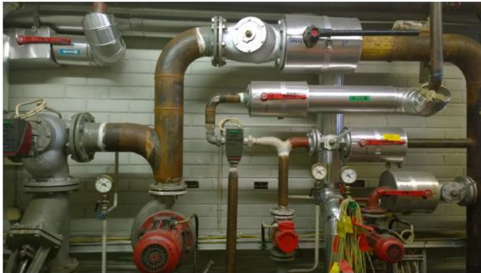
Kuva 2. Lämmönjakohuoneen toisiopuolen putkiasennuksia.
