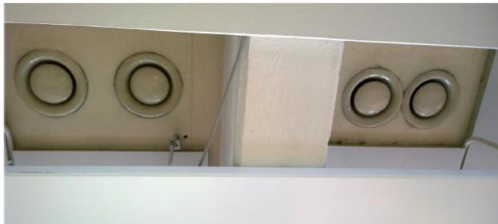
Kuva 8. Osa poistoilmakanavista menee suoraan betoniin
