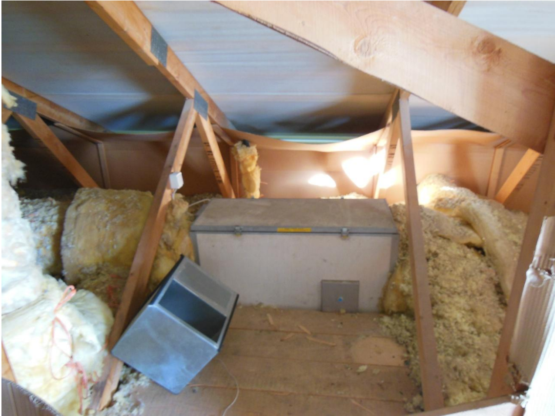
KUVA 5. Tuulenojainpahvit ohjaavat ilmavirtaa niin, ettei puhallusvilla liiku
