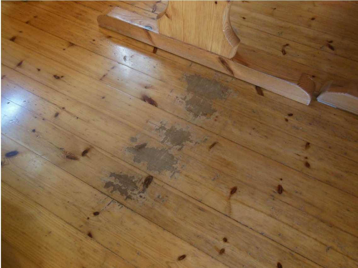
KUVA 9. Huopatarroista huolimatta kalusteet ovat aiheuttaneet kulumia lattiaan
