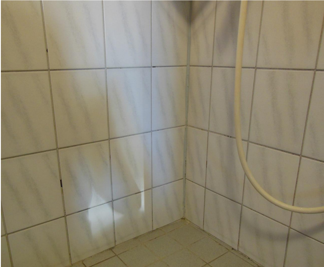
KUVA 6. Suihkunurkkauksessa on eniten vaurioita pinnoissa
