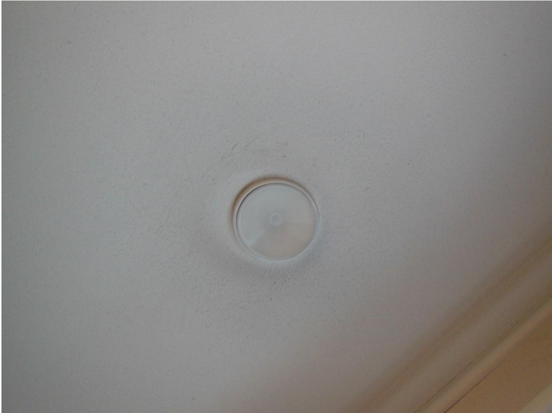
KUVA 8. Tuloilmaventtiin ympärillä on tummentumaa
