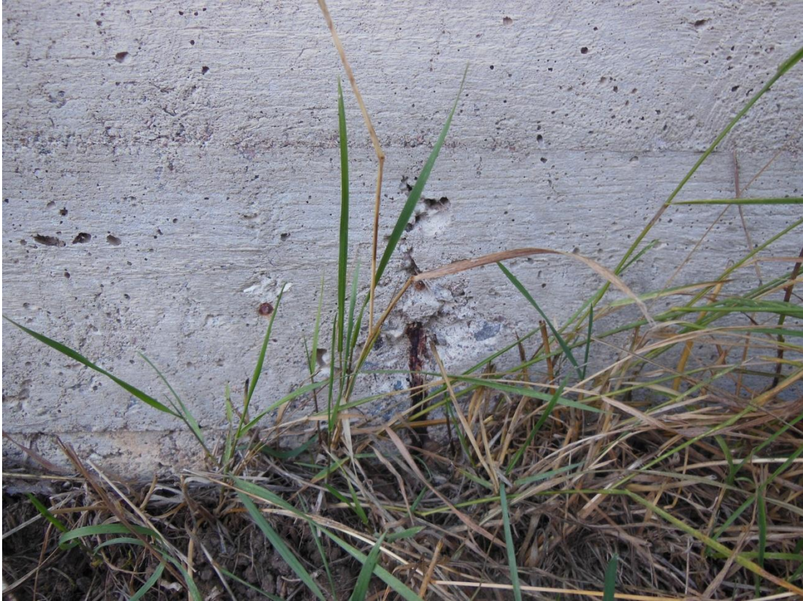
KUVA 1. Ruostunut harjateräs näkyvillä
