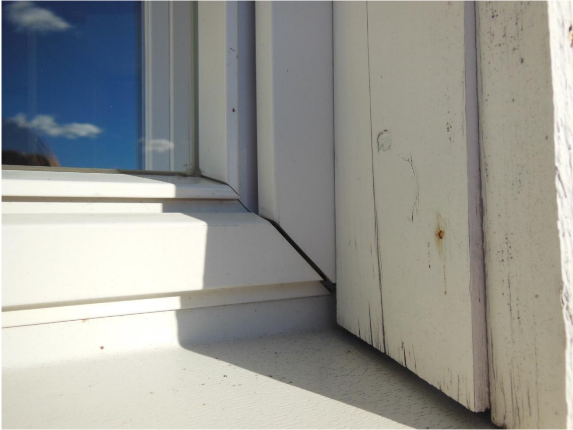
KUVA 2. Ikkunoiden karmeissa on rakoja
