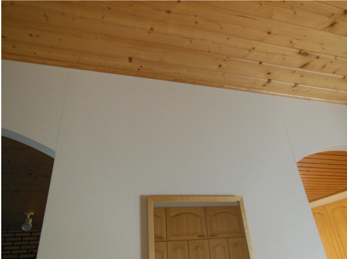
KUVA 7. Levyjen saumat ovat halkeilleet
