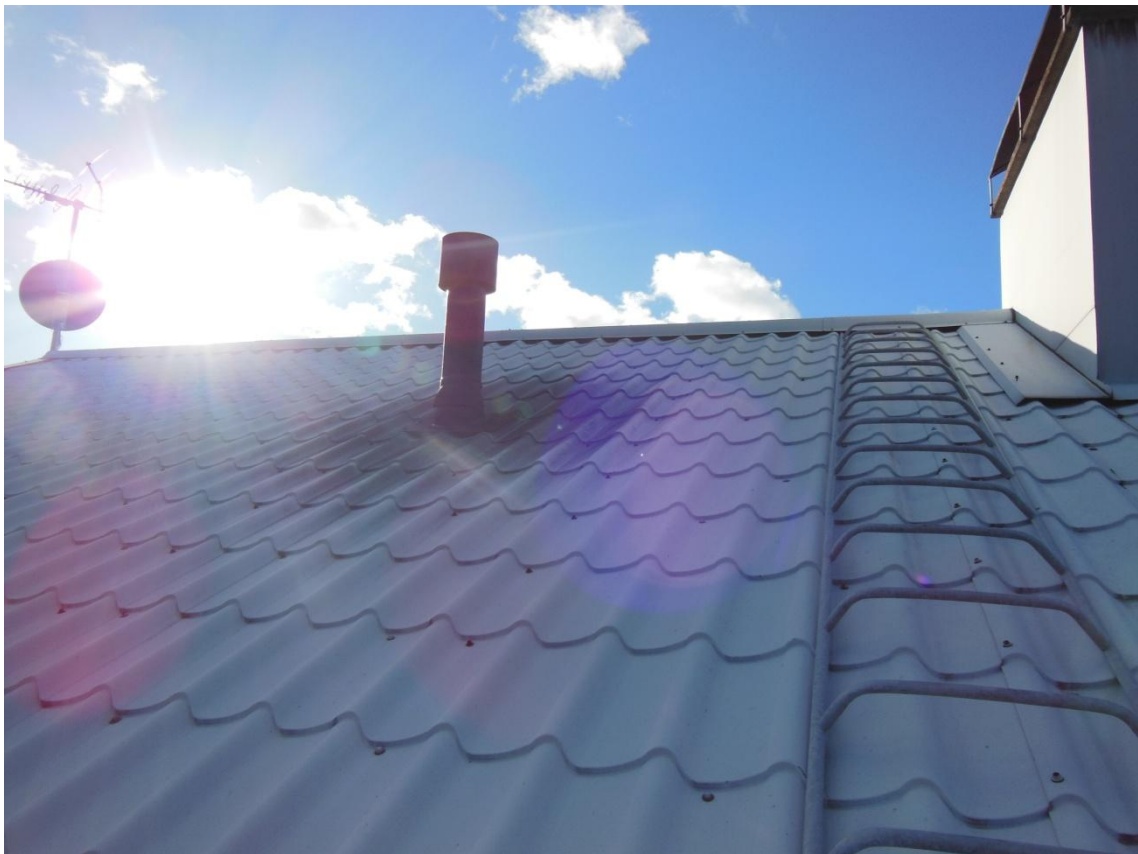
KUVA 3. Ilmanvaihdon poistoputken ympäristys on mustunut mahdollisesti noesta
