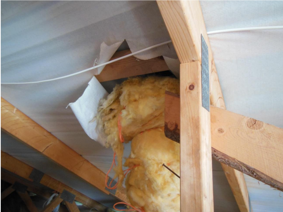
KUVA 4. Aluskatetta ei ole nostettu läpivientien kohdalla tiiviisti
