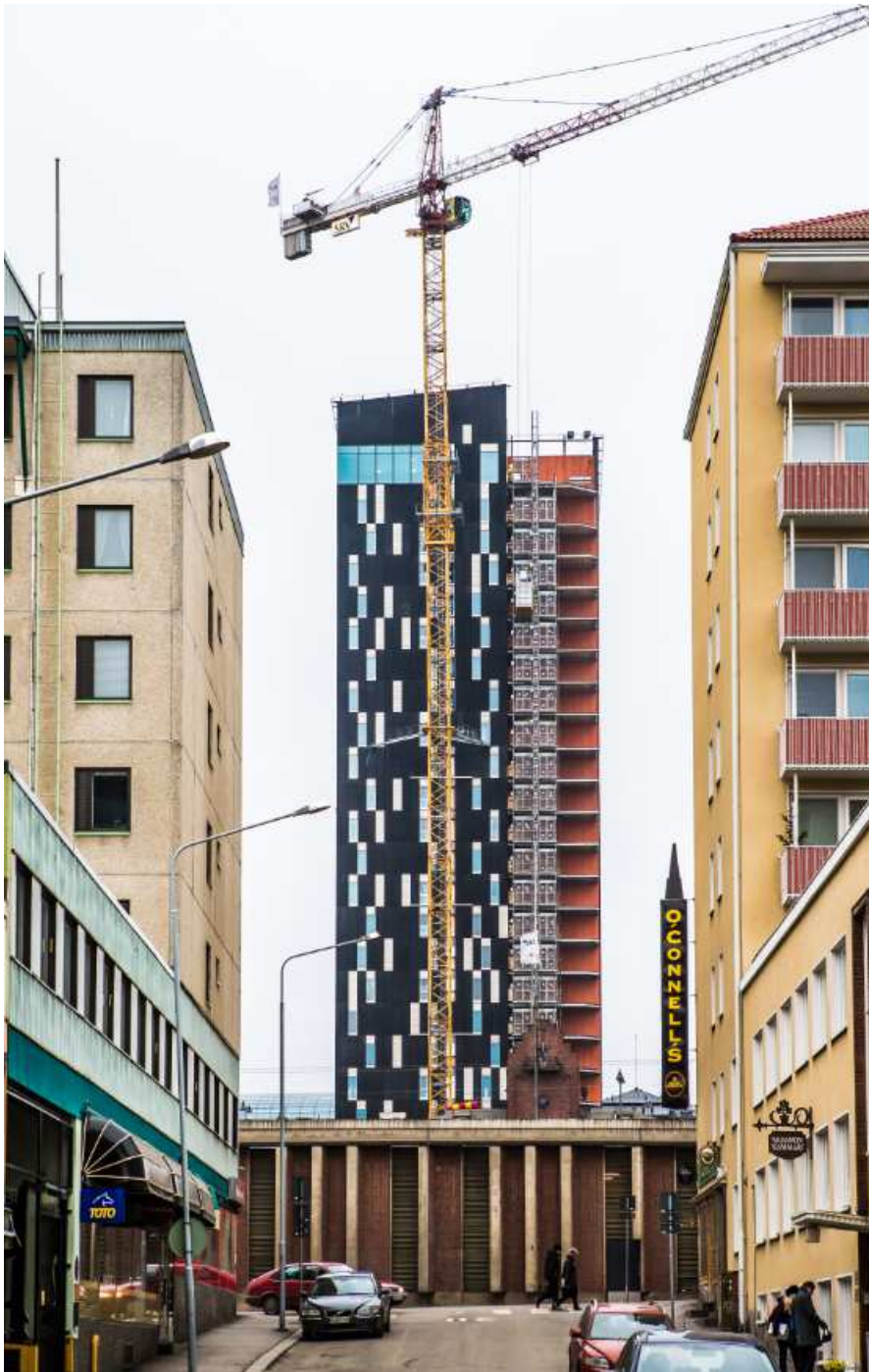
KUVA 12 Tampereen Tornihotelli, betonielementit asennettu, työmaavaihe (Parma Oy)
