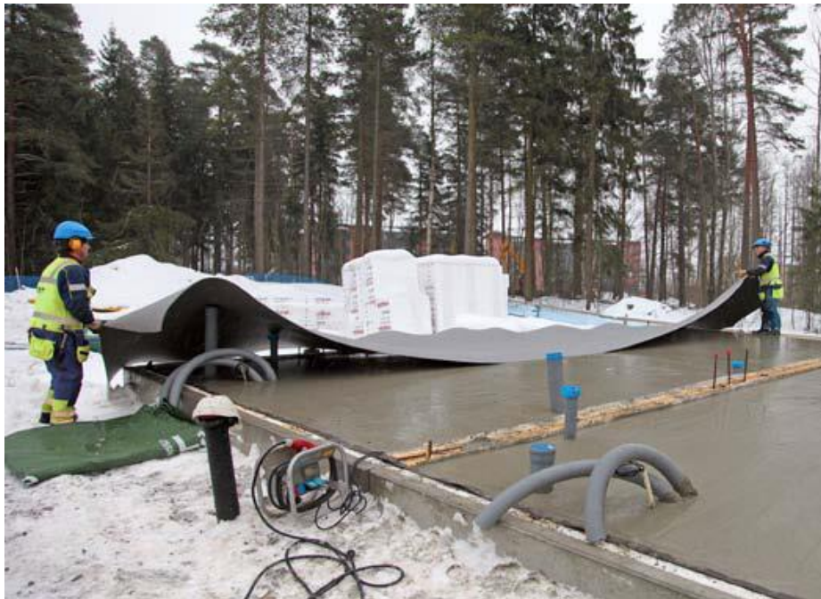
KUVA 3. Lattiavalun lämpösuojaaminen käynnissä (8, s. 39)
