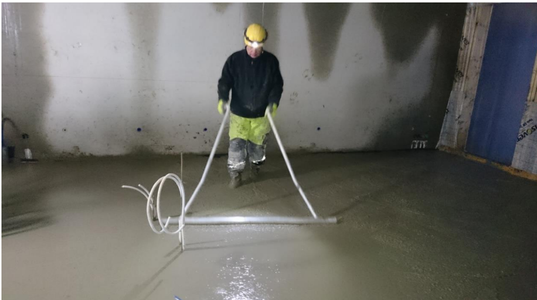
KUVA 5. Hyssytys käynnissä, kuvasta näkee kertaalleen tasoitetun alueen rajan
