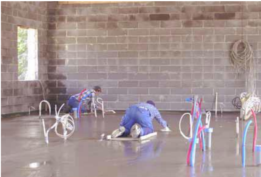
KUVA 1. Betonilattian hierto käynnissä (3, s. 27)
