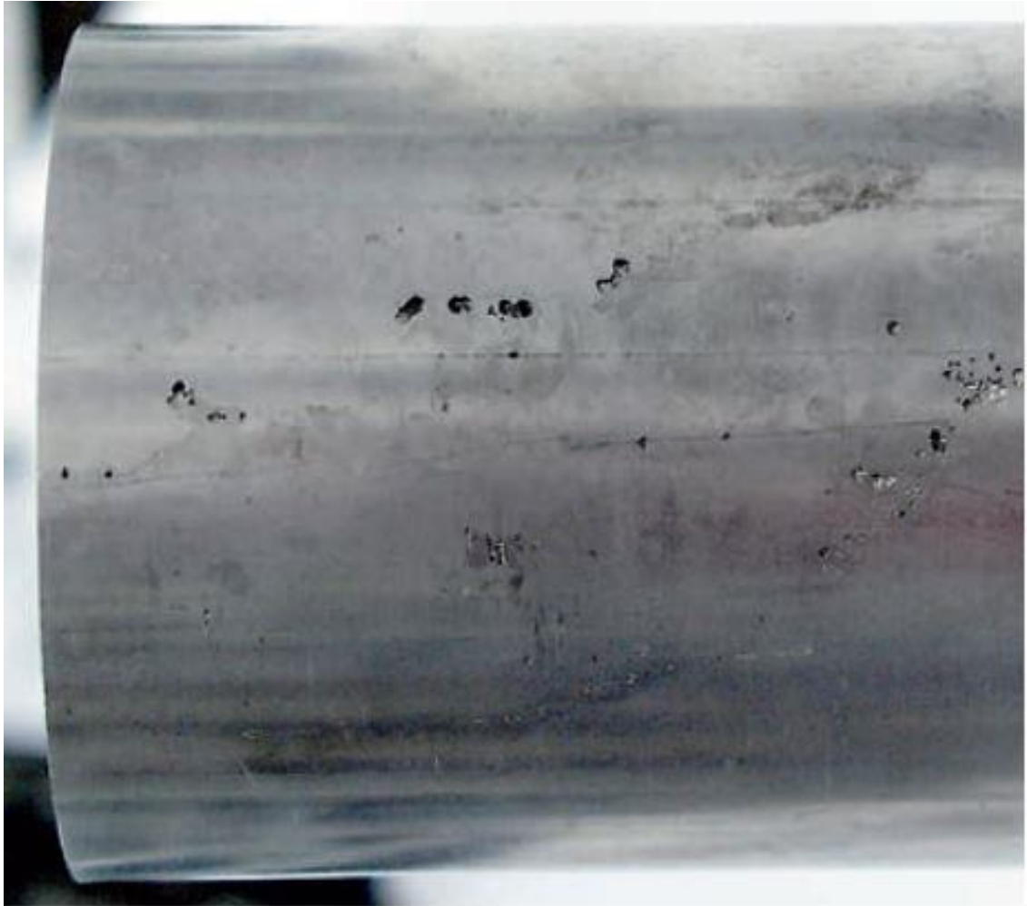
Kuva 8. Pistekorroosiota putken ulkopinnassa [5]
