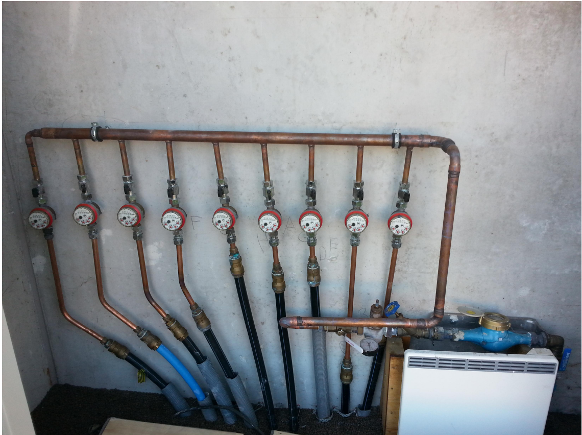
Kuva 3. Taloyhtiön jakotukki.
