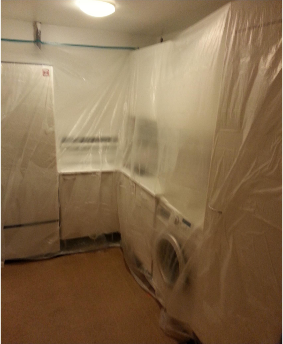
Kuva 1. Suojattu pesuhuone.
