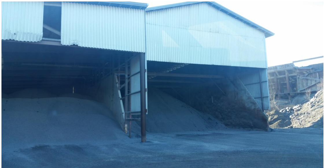
Kuva 3. Varastointihalli, ilma-kuivattu hiekoitussepeli.
