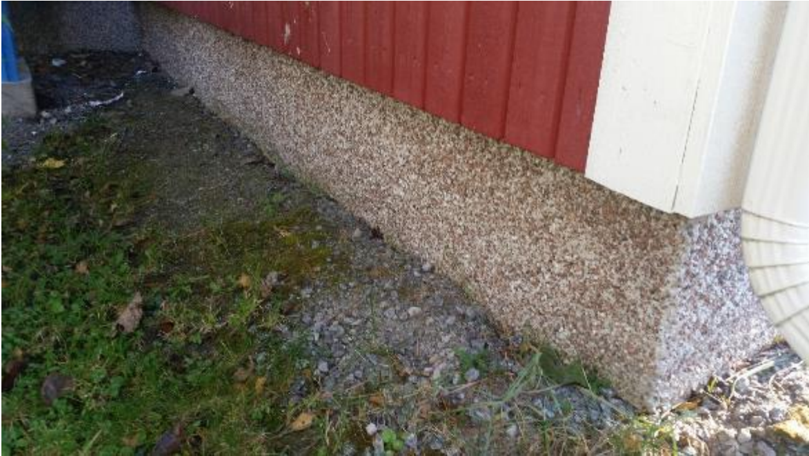
Kuvio 1. Kivirouheella pinnoitettu sokkeli.
