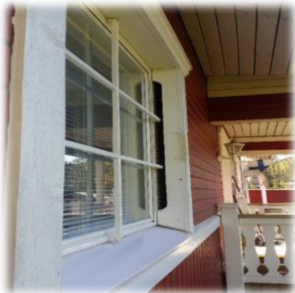
Kuvio 39. Ikkunapellitys kunnossa.
