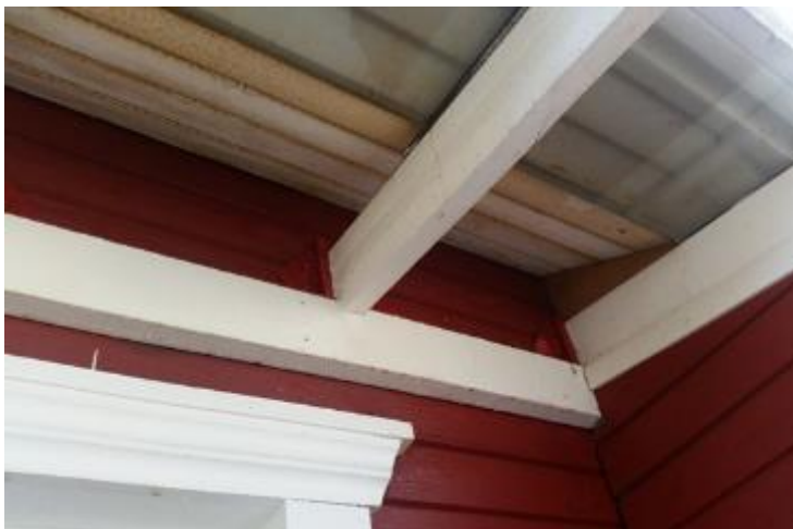
Kuvio 34. Räystäslaudat ovat värjäytyneet.
