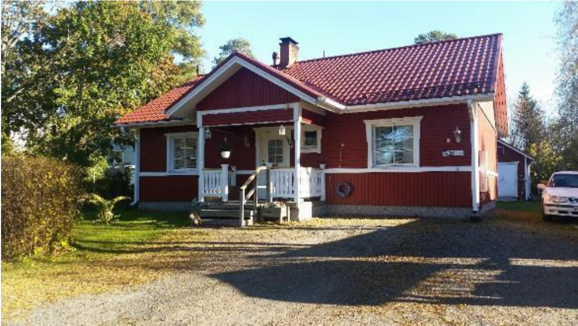
Kuvio 3. Maanpinta kallistaa pois päin rakennuksesta.
