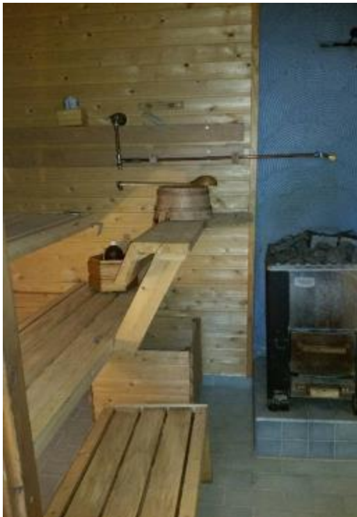
Kuvio 60. Saunan lauteet ovat käytössä kuluneet.
