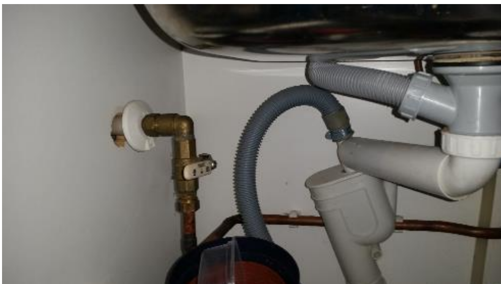
Kuvio 61. Keittiön kaapissa sijaitsevat putket ja liitännät olivat kuivia eikä vuotojälkiä havaittu.
