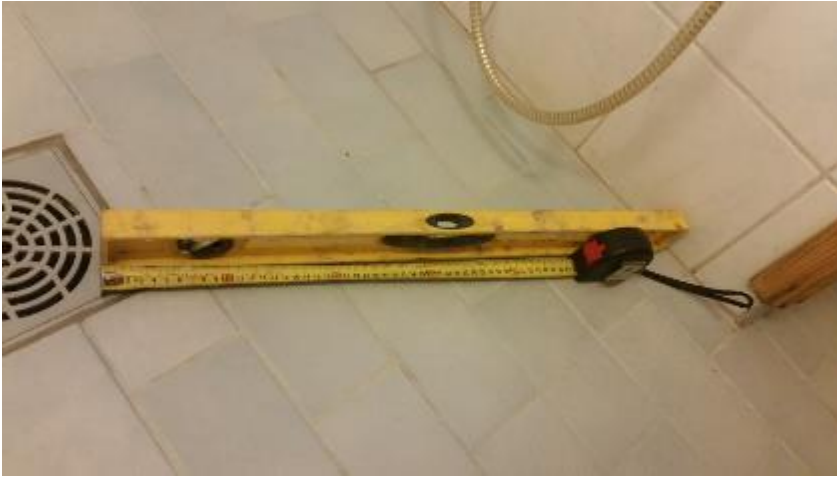
Kuvio 25. Kallistuksen tarkastukseen tarvitaan vesivaaka ja mitta.
