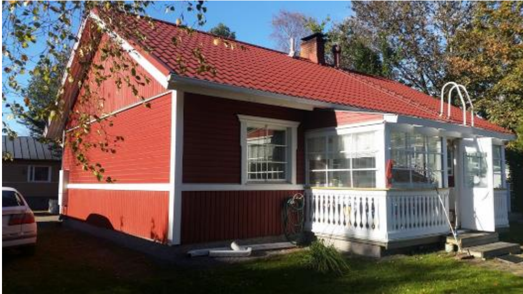
Kuvio 37. Julkisivua takapihalta.
