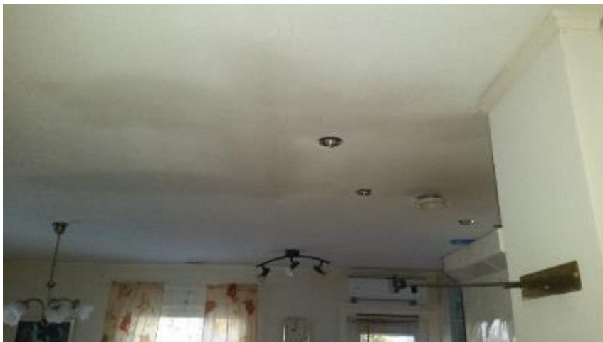
Kuvio 20. Keittiössä ja olohuoneessa on roisketasoitettu kipsilevykatto.
