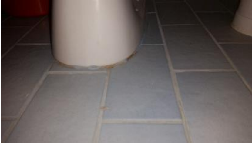
Kuvio 23. Lattiassa silikonisaumat ja saumalaasti ovat värjäytyneet.
