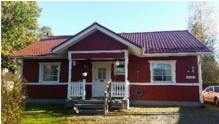
Kuvio 10. Rakennuksessa on profiilipeltikate.
