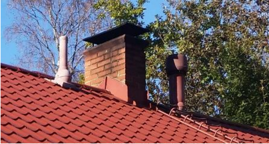
Kuvio 11. Vesikatteen läpiviennit.
