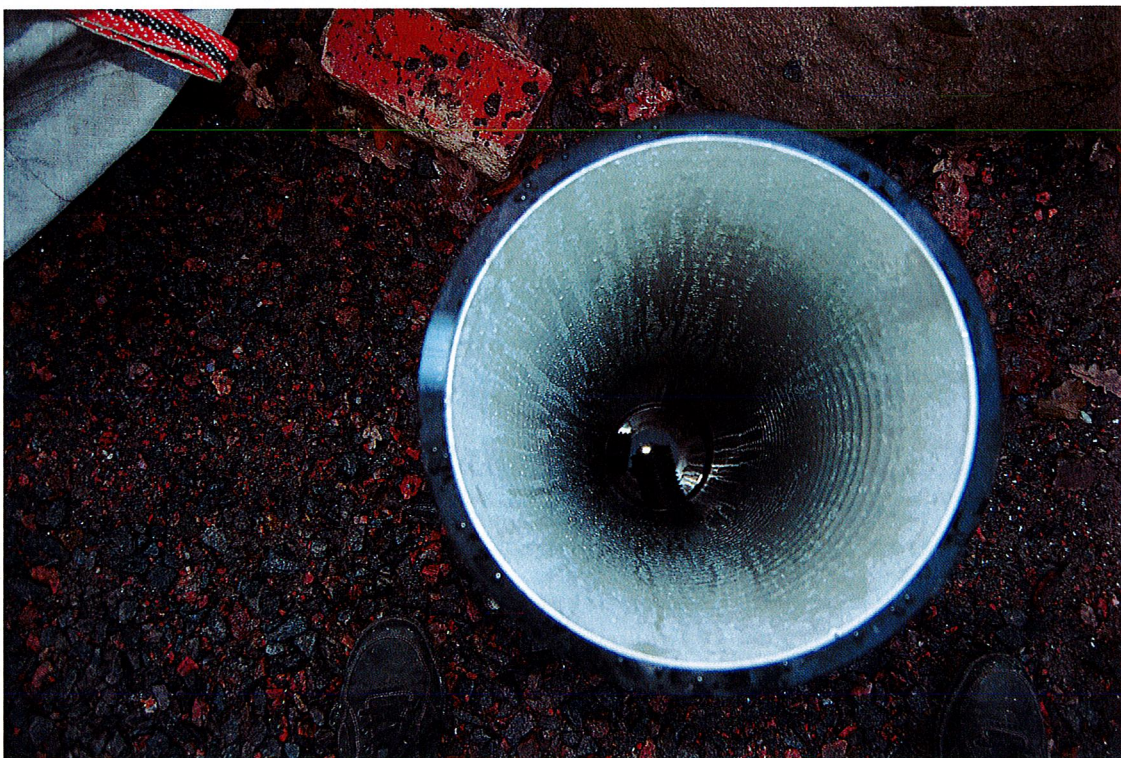
Kuva 48. Salaojan tarkastuskaivo.
