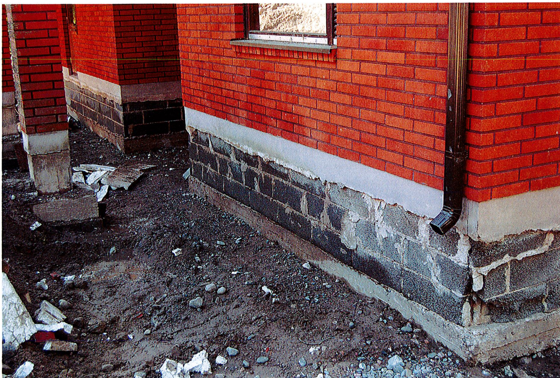
Kuva 21. Perustukset niiden auki kaivutöiden jälkeen.
