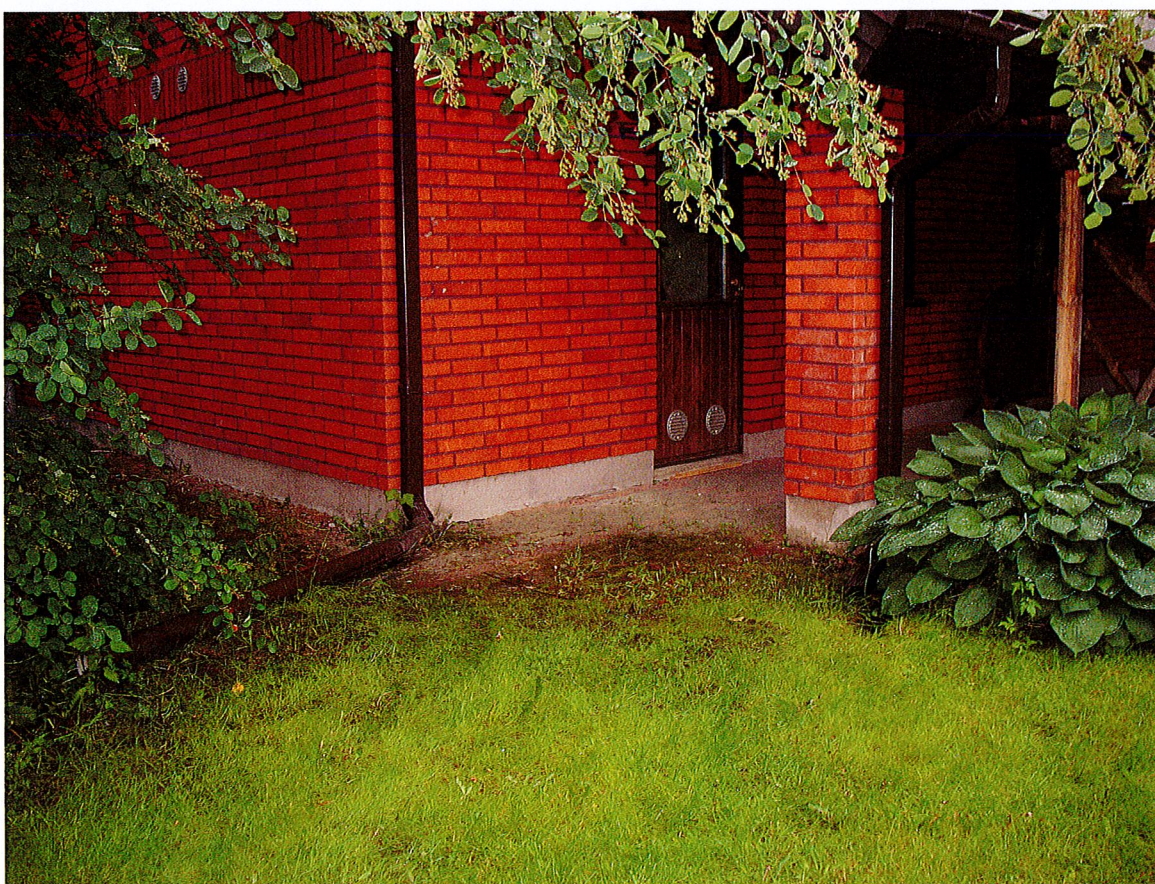
Kuva 8. Syöksytorvi, jonka jatkoksi asennettiin jatko sadevesien johtamiseksi ojaan.
