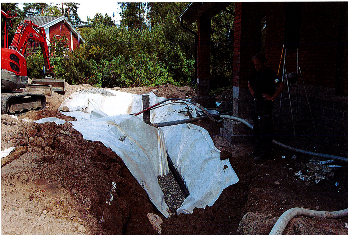
Kuva 28. Salaojajärjestelmän asennustyöt aloitettiin perjantaina 14.8.2015.
