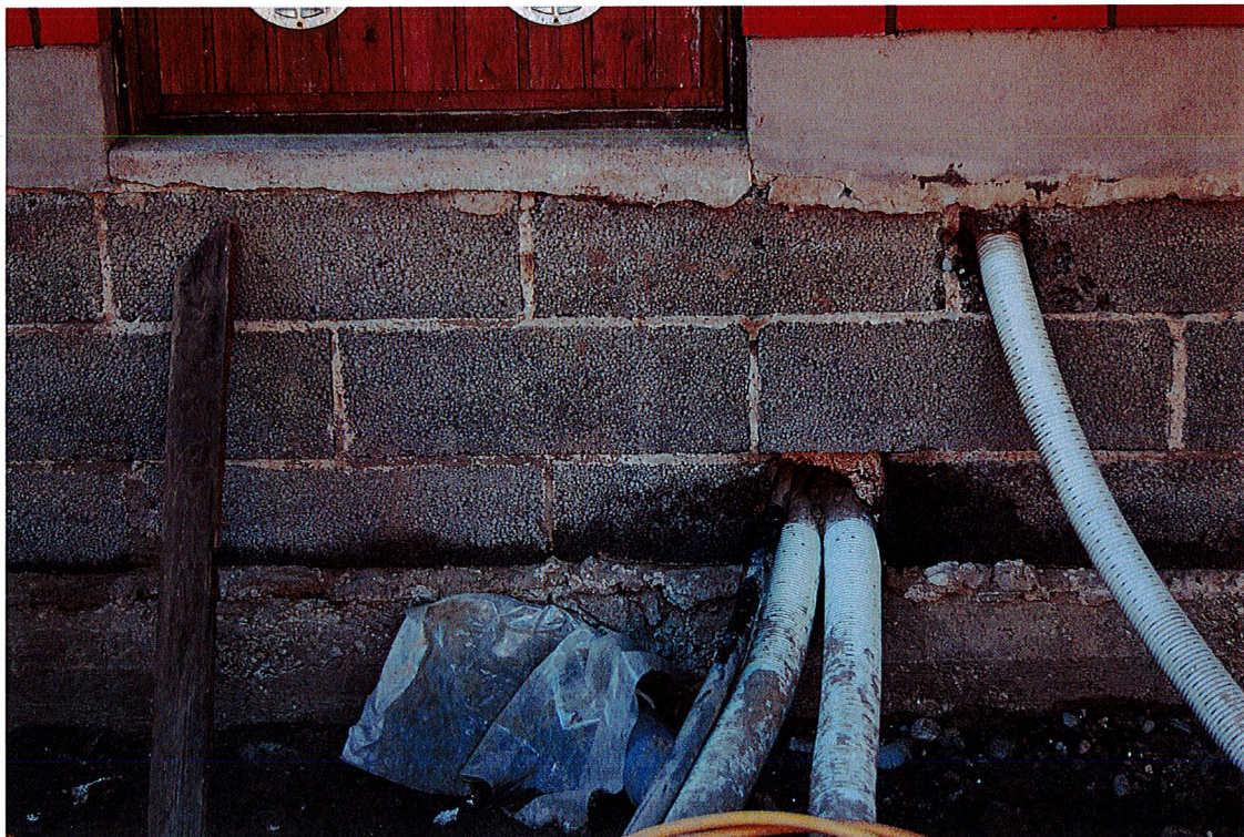
Kuva 23. Sokkelin läpiviennit.
