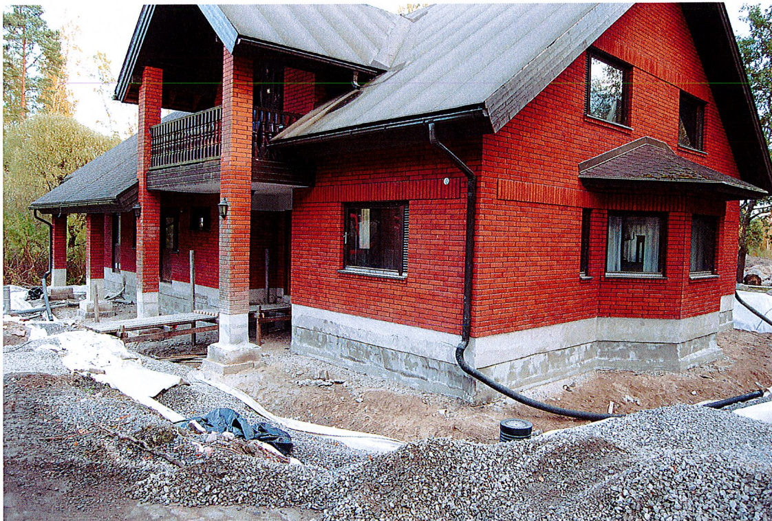
Kuva 36. Sokkelin työvirheiden korjaustyöt valmiina.
