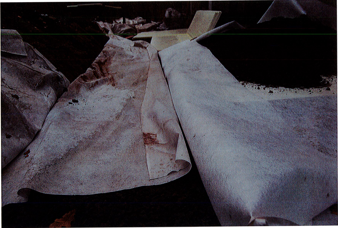
Kuva 46. Suodatinkankaan limitys routaeristelevyjen päällä.
