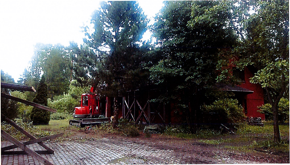
Kuva 19. Näkymä ennen raivaus- ja kaivutöiden aloitusta.
