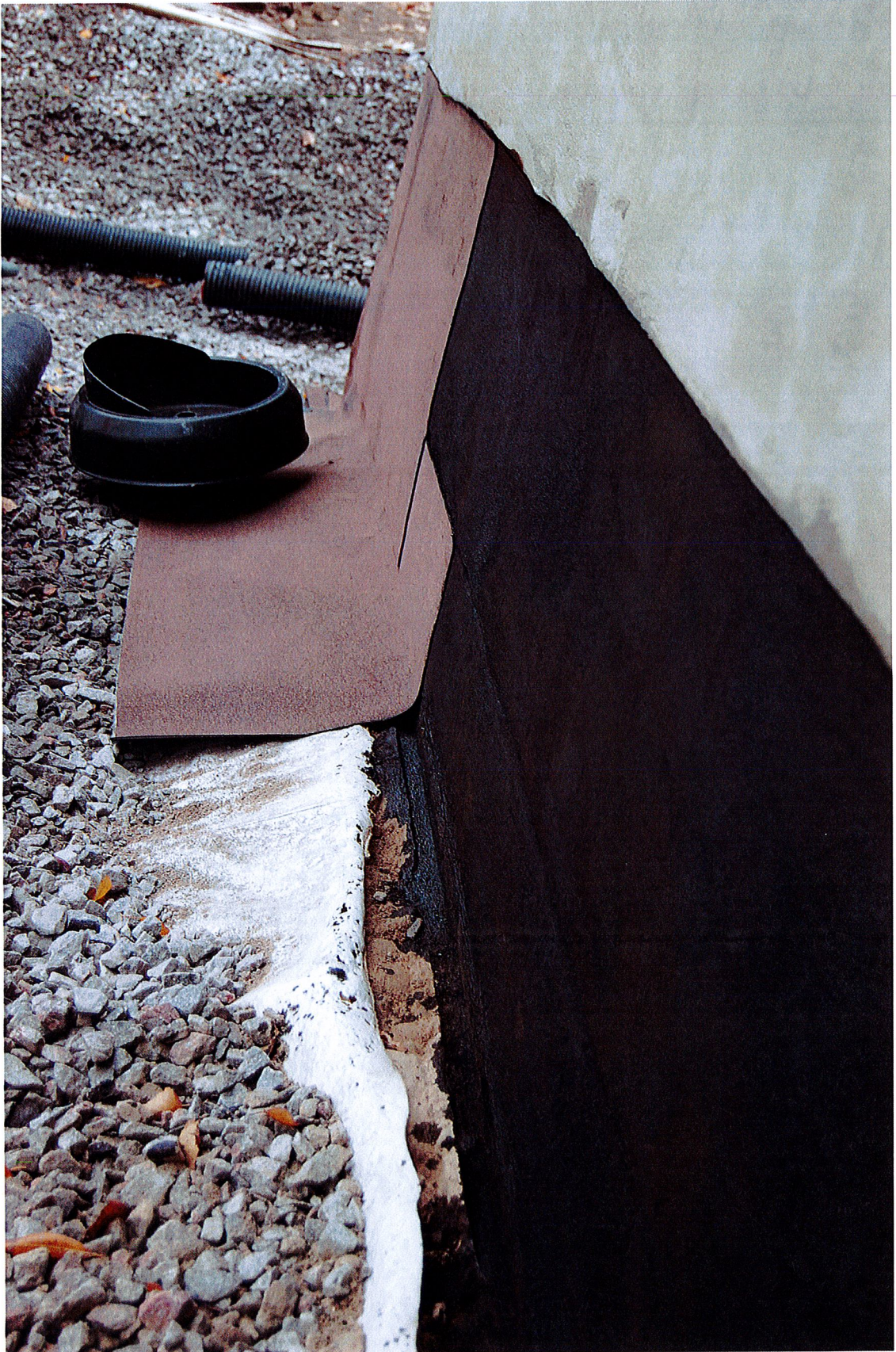
Kuva 40. Sokkelihuovan kiinnitystä.
