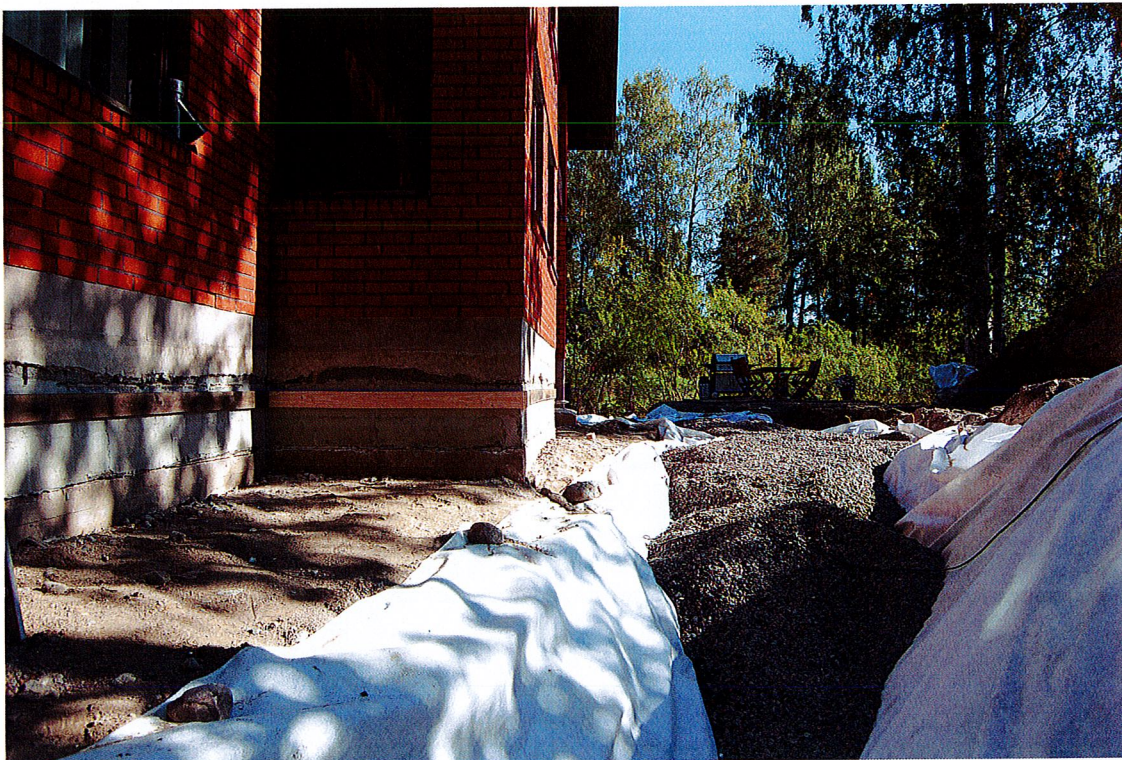
Kuva 32. Sokkelin tasoite-/pinnoitetyöt aloitti eräs työryhmä torstaina 10.9.2015.
