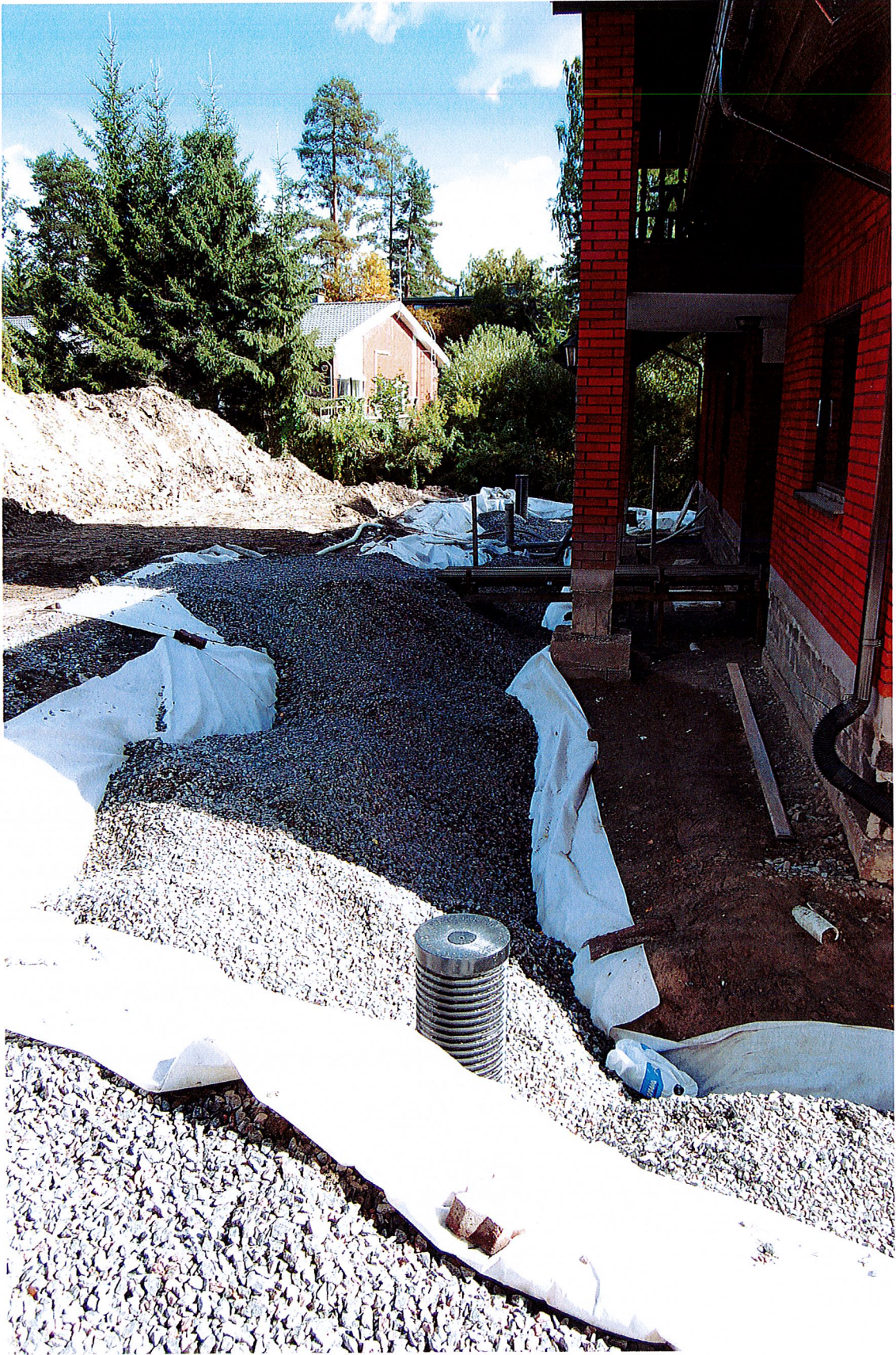
Kuva 30. Salaojan ympärystätyöt käynnissä 29.8.2015.
