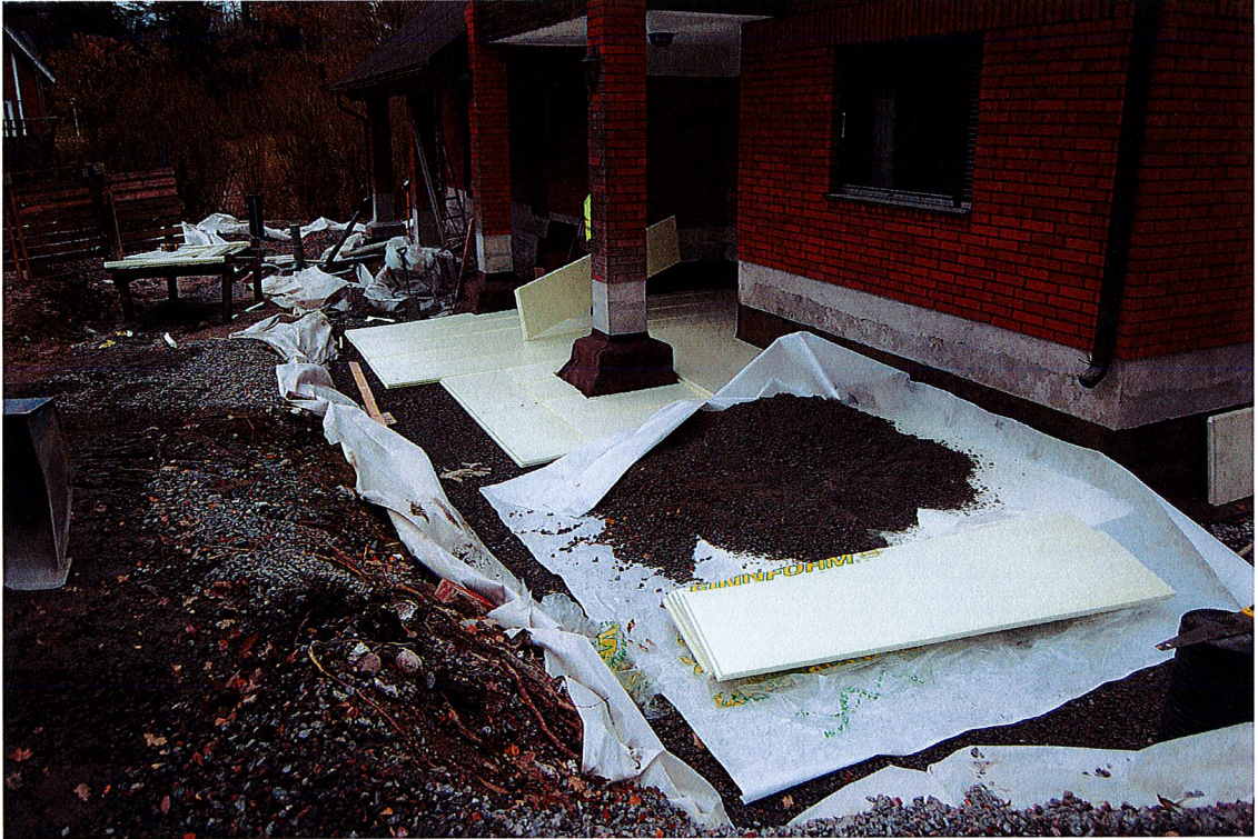
Kuva 45. Pääsisäänkäynnin edustalla routaeristeiden levitystyöt käynnissä.
