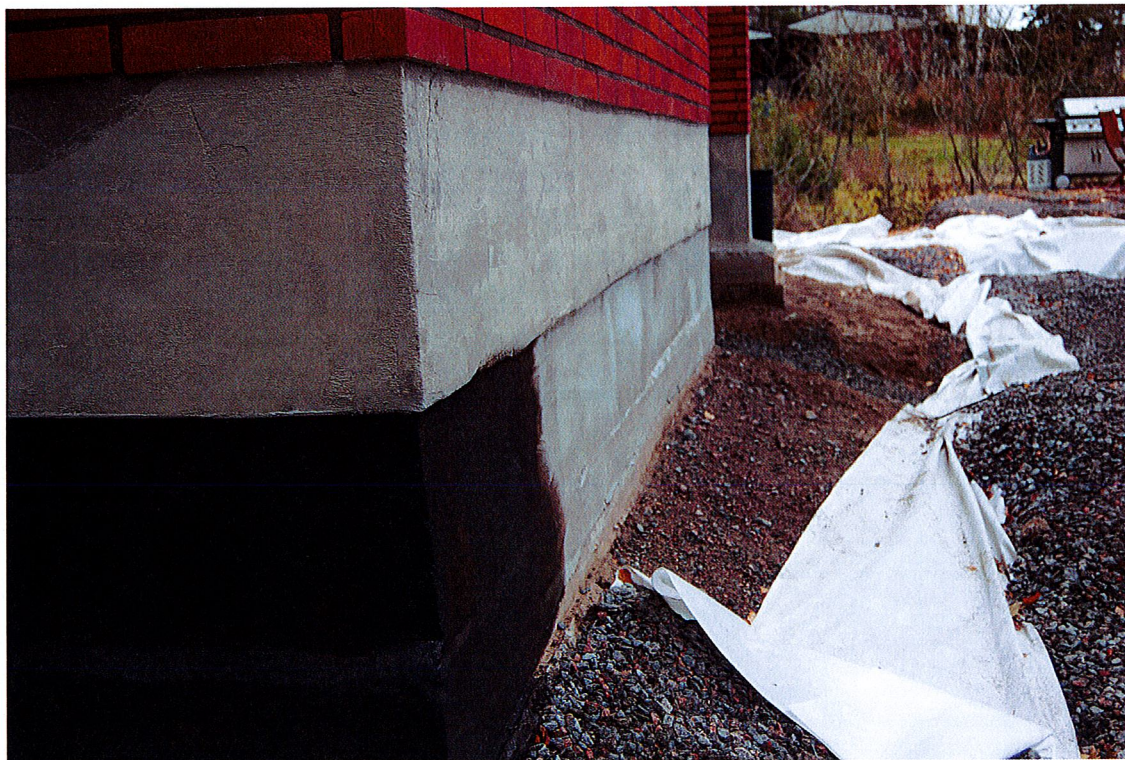
Kuva 39. Sokkelin bitumiliuossively.
