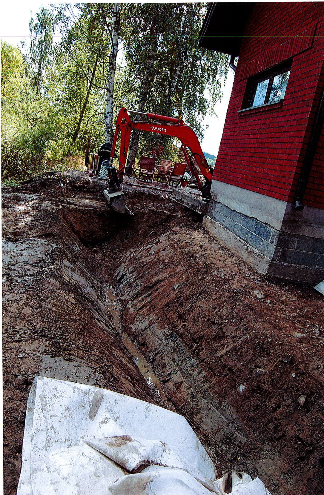
Kuva 29. Salaojan kaivutyöt rakennuksen itäpuolella.
