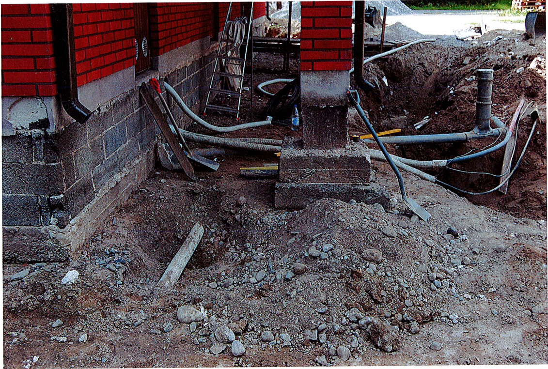
Kuva 25. Rakennuksen alkuperäisen salaojaputken korkeusasema.
