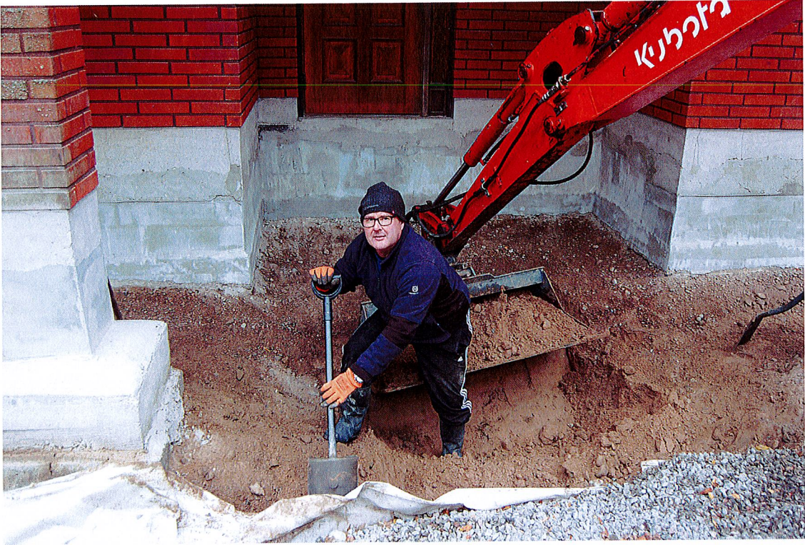
Kuva 43. Kuvassa suoritetaan massanvaihtoa pääsisäänkäynnin edustalla.
