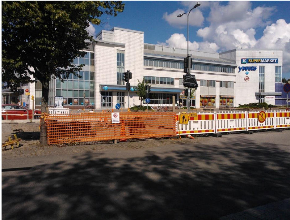
Kuva 1. HSY:n vesijohto- ja viemäriverkoston saneeraustyömaa Vantaalla Tikkurilassa kesällä 2014 (Marika Sirkiä, Vantaan kaupunki)
