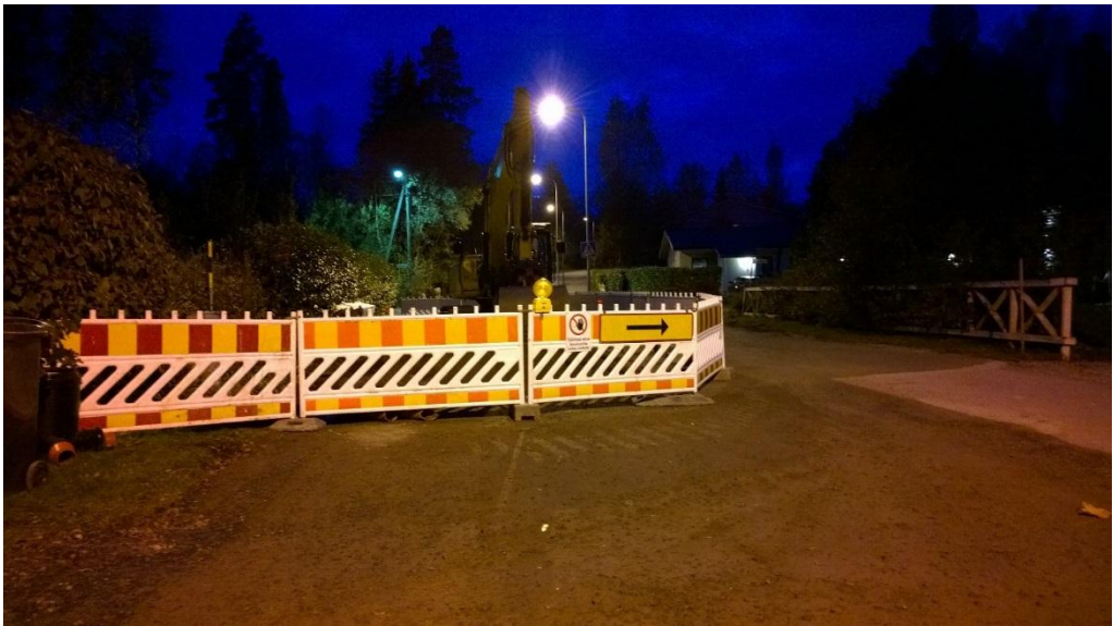
Kuva 6. Työalue tulee eristää suoja-aidoilla, sulkupuomeilla ja pylväillä ohjeita noudattaen.
