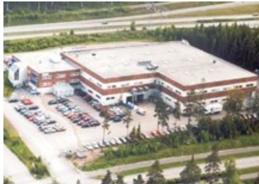
Kuva 15 Eaton Power Quality Oy:n tehdasrakennus Espoossa /12/
