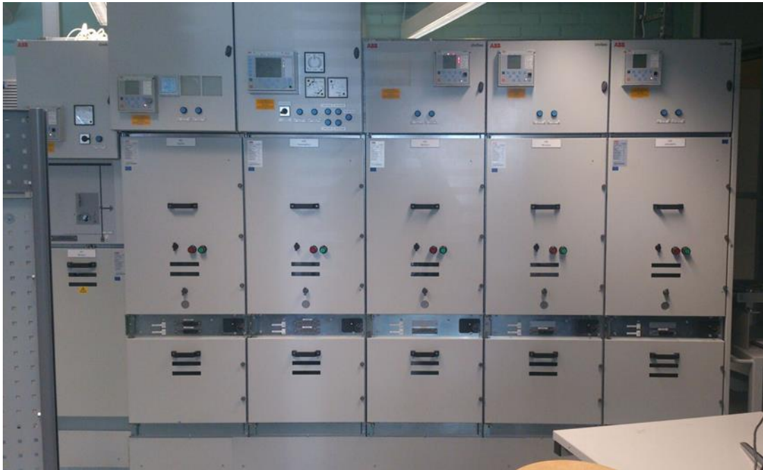
Kuva 10. 10 kV kojeisto.
