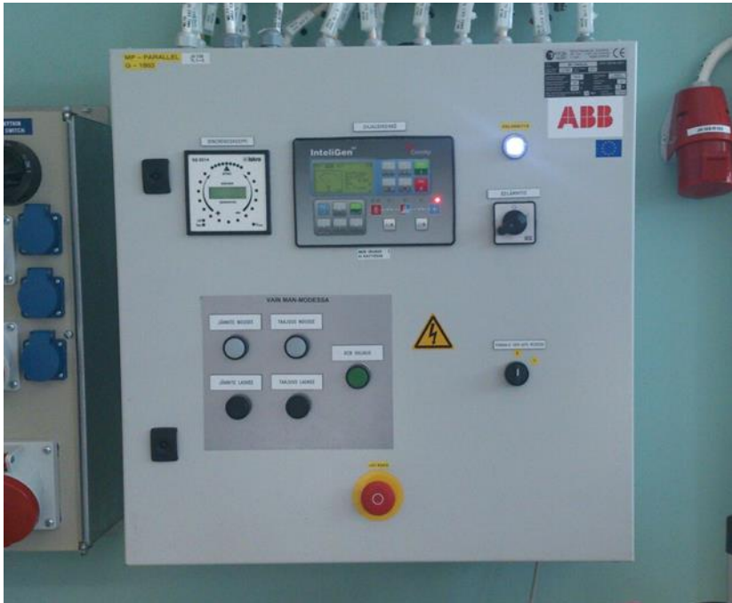
Kuva 8. Generaattorin ohjauspaneeli.
