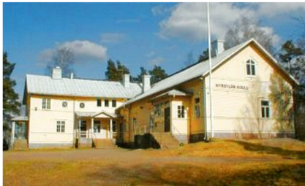
Kuva 6: Koulurakennuksiin laitetila saadaan sijoitettua edullisesti. /11/
