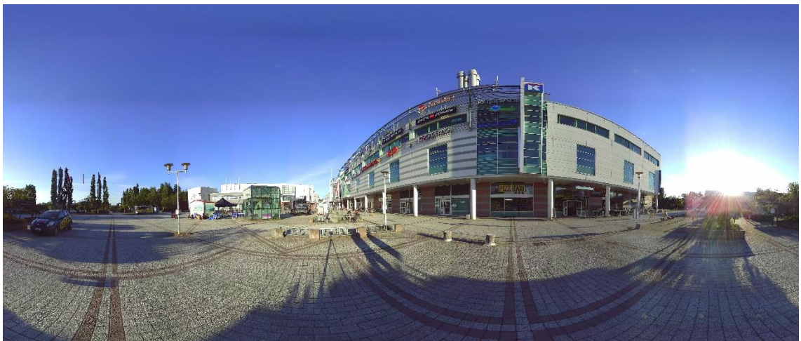
Kuva 13. Skannerin tuottama 360° panoraamakuva julkisivusta
