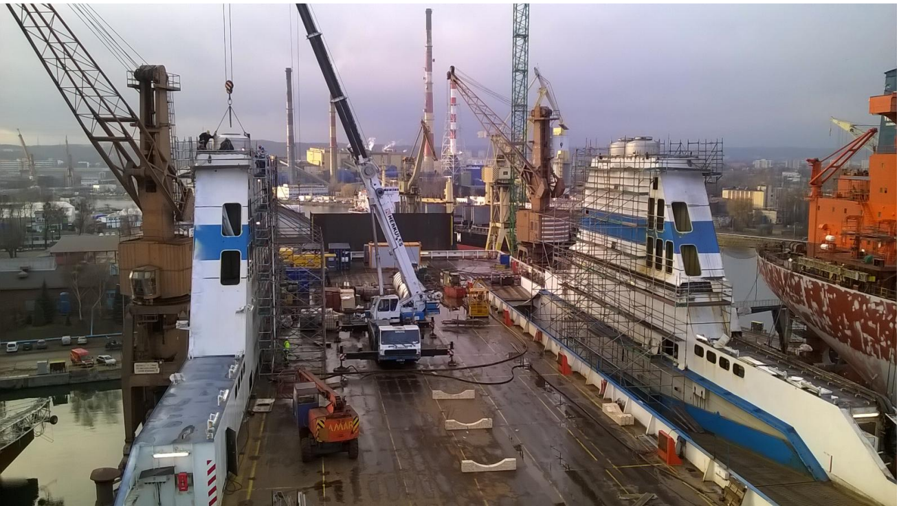
Kuva 17. Pakokaasupesureiden asennusta paikoilleen
