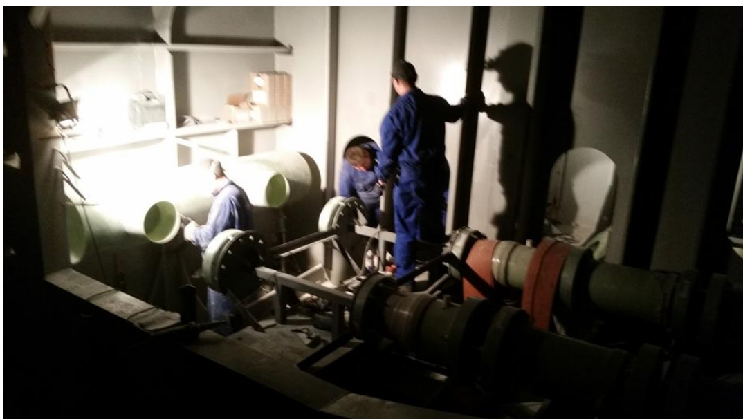
Kuva 11. Merivesiputkien asennusta tulevaan laitehuoneeseen
