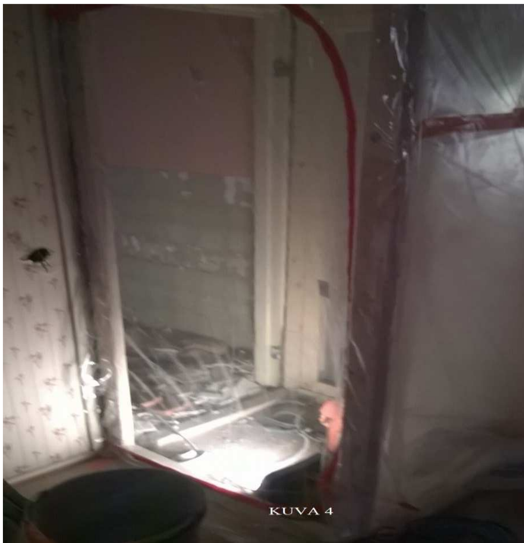
Kuva 4 Kohteessa testattu sulkuhuone kylpyhuoneen eteen (Kuvannut: Matti Poskiparta)
