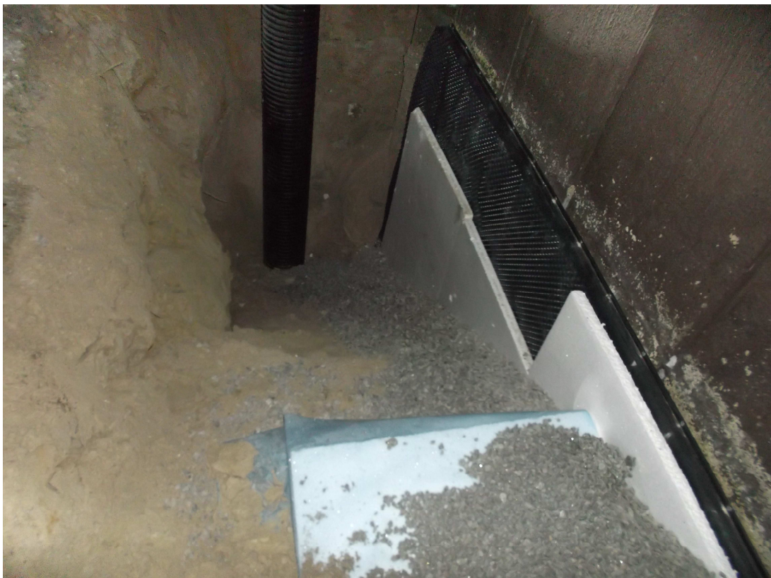
Kuva 1 Tiilimäentie 8 ulkopuoliset kaivuutyöt (Kuvannut: Matti Poskiparta)
