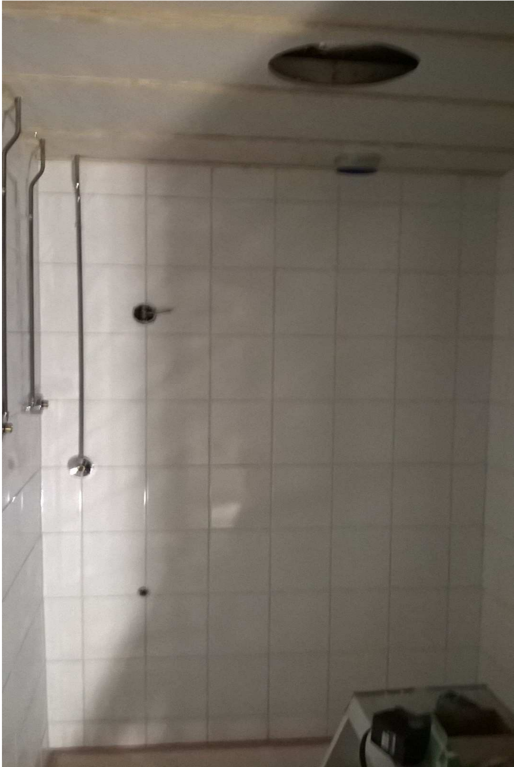
Kuva 7 Kylpyhuoneen laatoitettu ja alakattotyöt käynnissä. (Kuvannut: Matti Poskiparta)
