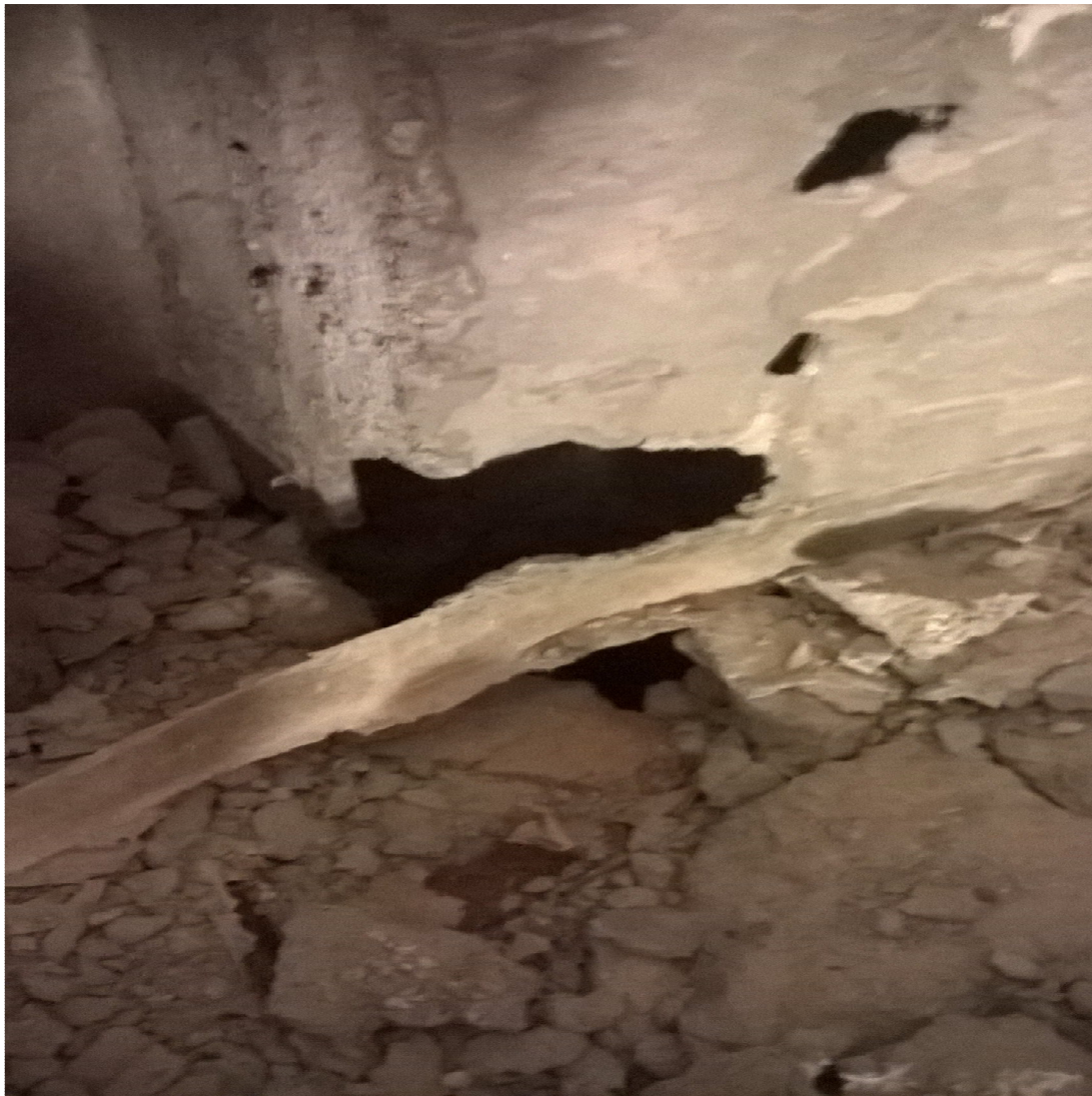
Kuva 6 Tekniikkahormin purkutöiden yhteydessä havaittu ilmahormin rikkoutuneen (Kuvannut: Matti Poskiparta)
