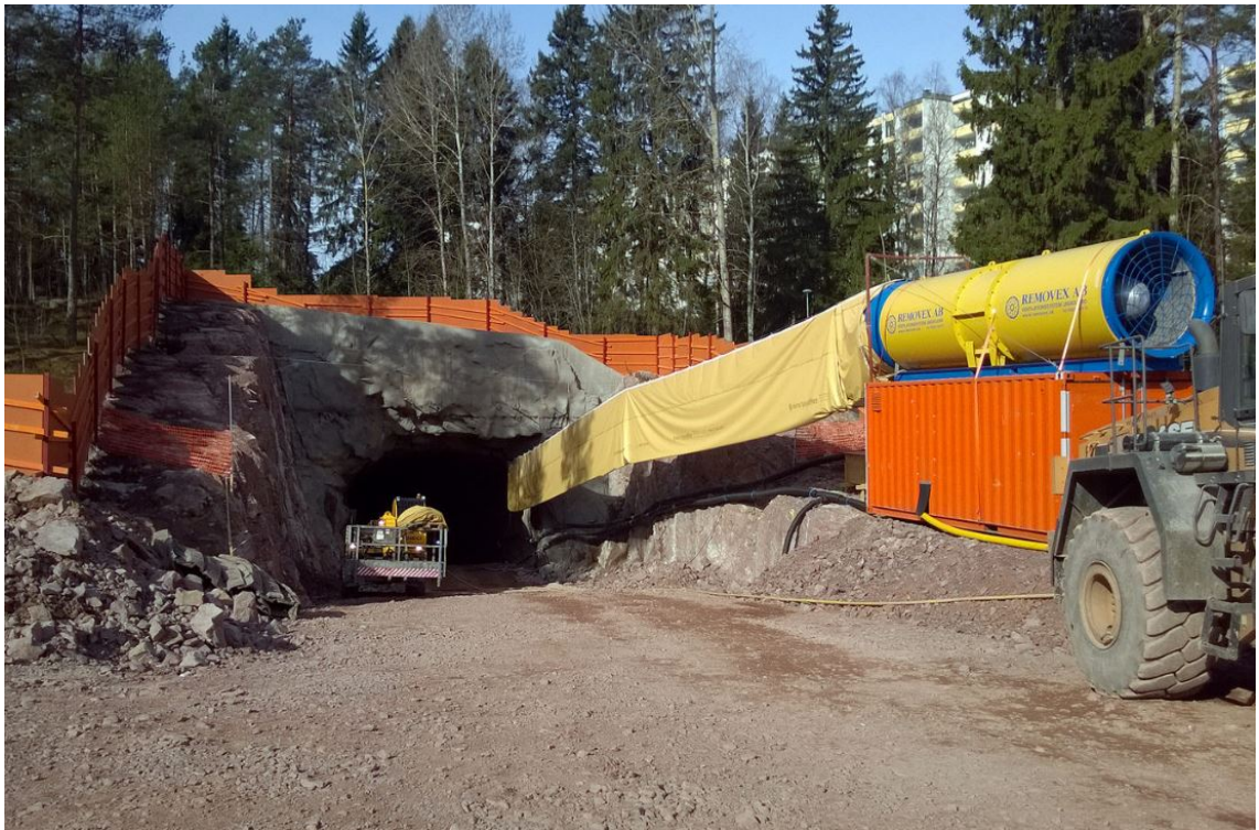
Kuva 1. Soukan ajotunnelin suuaukko. (3)
