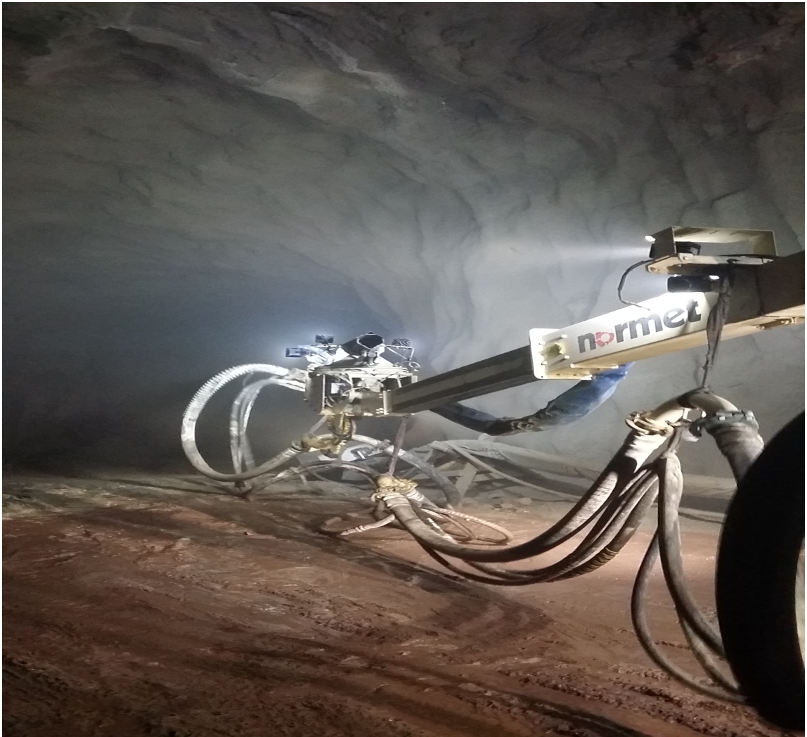
Kuva 5. Ruiskurobotin suutinpuomi. Kuva Soukan ajotunnelista. (2)
