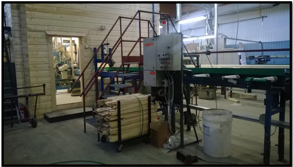
Kuvio 81. Jättilinjan höylä, jonka ympärille on rakennettu hirrestä rakennettu suojakotelo.
