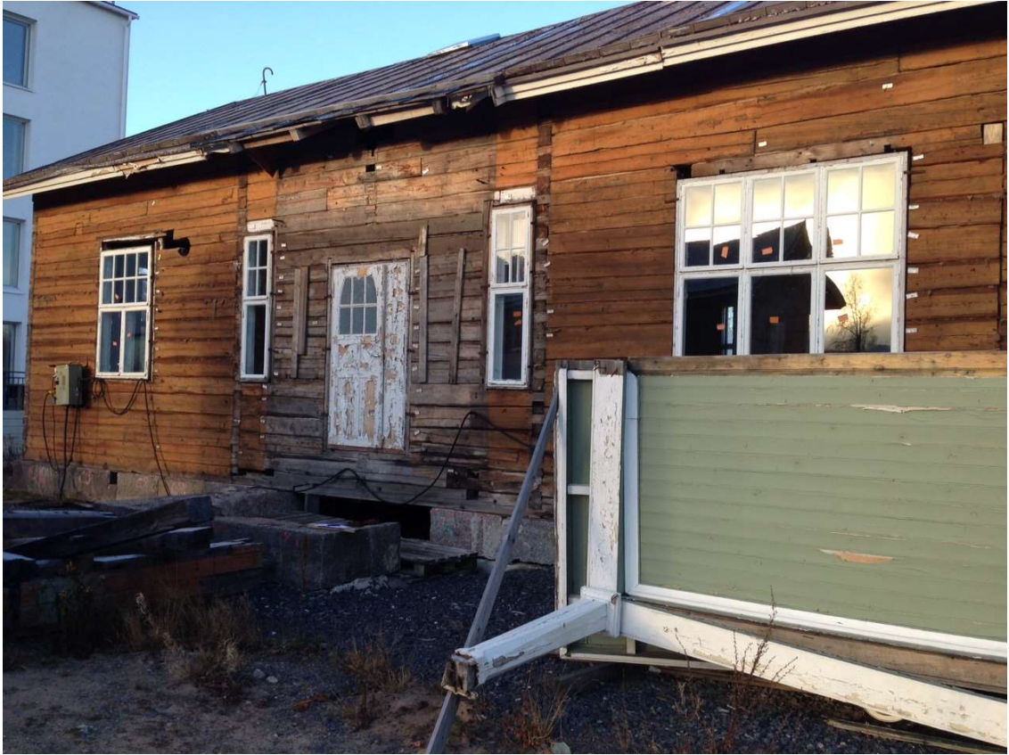
KUVA 11. Rakennus nykykunnossa, edessä pala vanhasta käyttökeltottomasta paneloinnista
