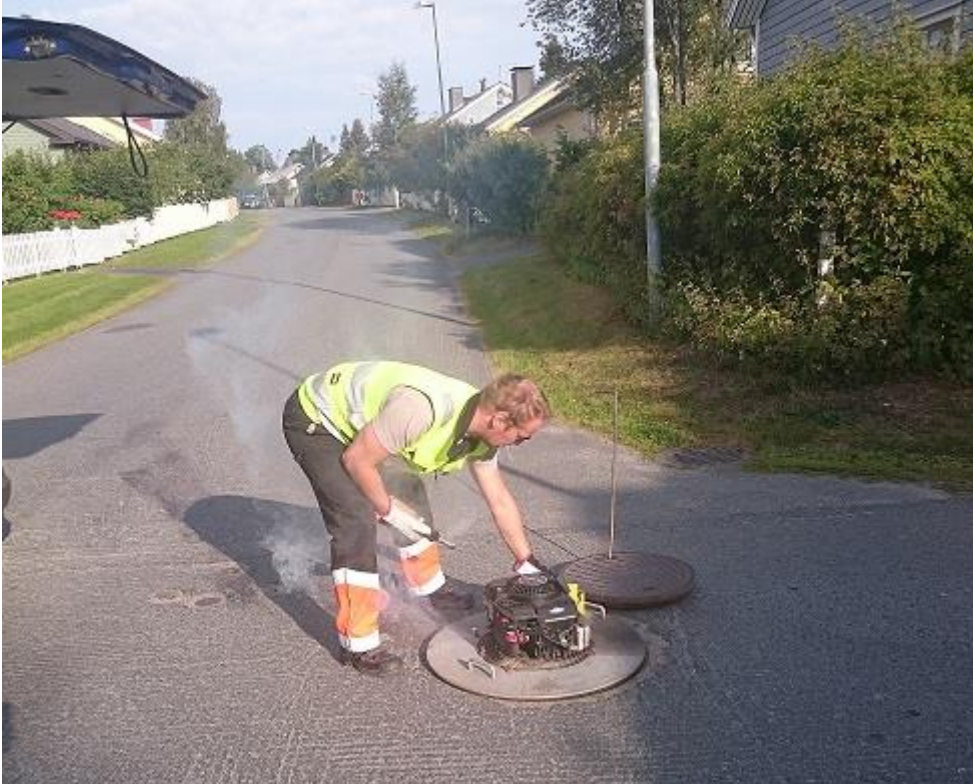
KUVA 11. Sytytetty savupatruuna laitetaan savukoneeseen
