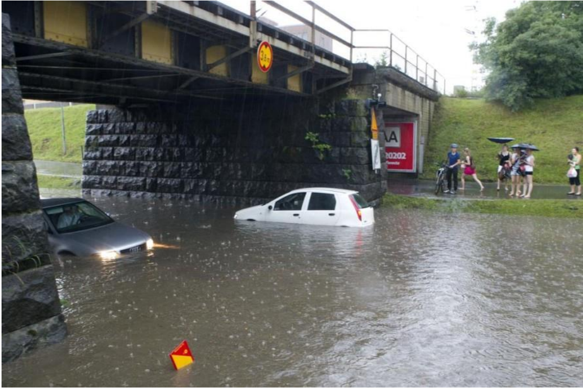
Kuva 3. Rankkasateiden aiheuttamaa tulvintaa alikulussa Oulussa
