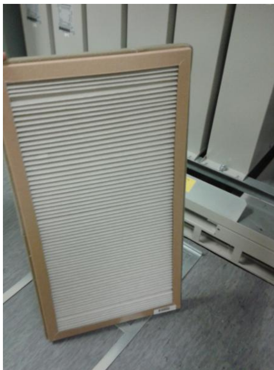
KUVA 14. Kompensointiyksikön ilmansuodattimen irrotus ja tarkastus (Taskinen 2015-08-27.)
