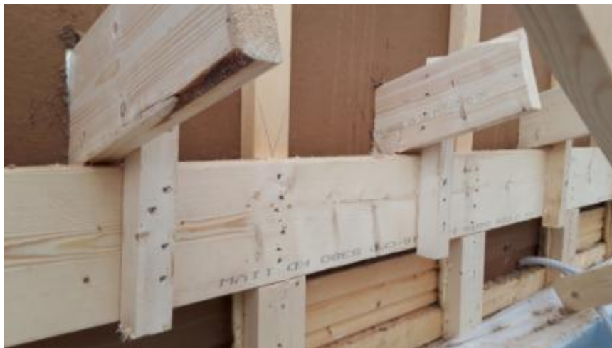
Kuva 10 Kuistin kattolankkujen tuennat.
