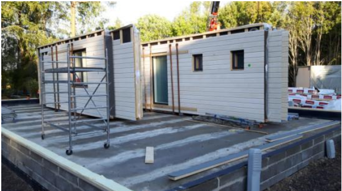
Kuva 4 Seinäelementtikollit nostettu tasaiselle alustalle.
