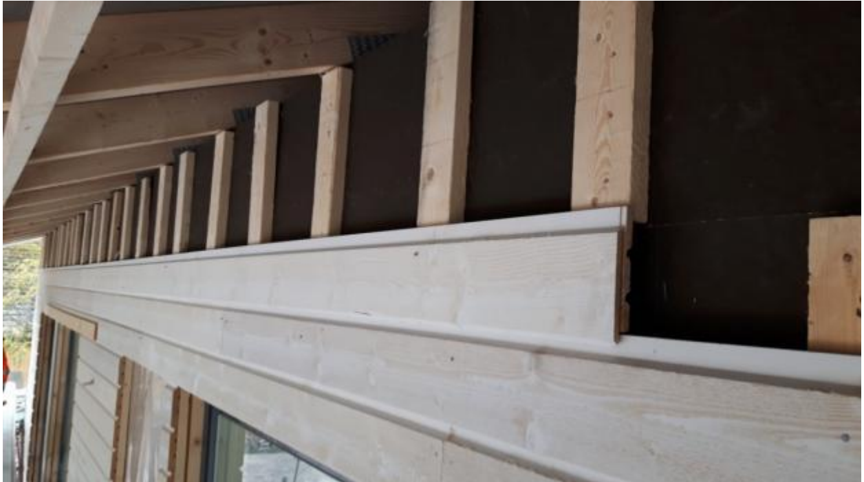
Kuva 15 Tuulensuojakuitulevy ja koolaukset asennettuna johon paneelausta voidaan jatkaa.
