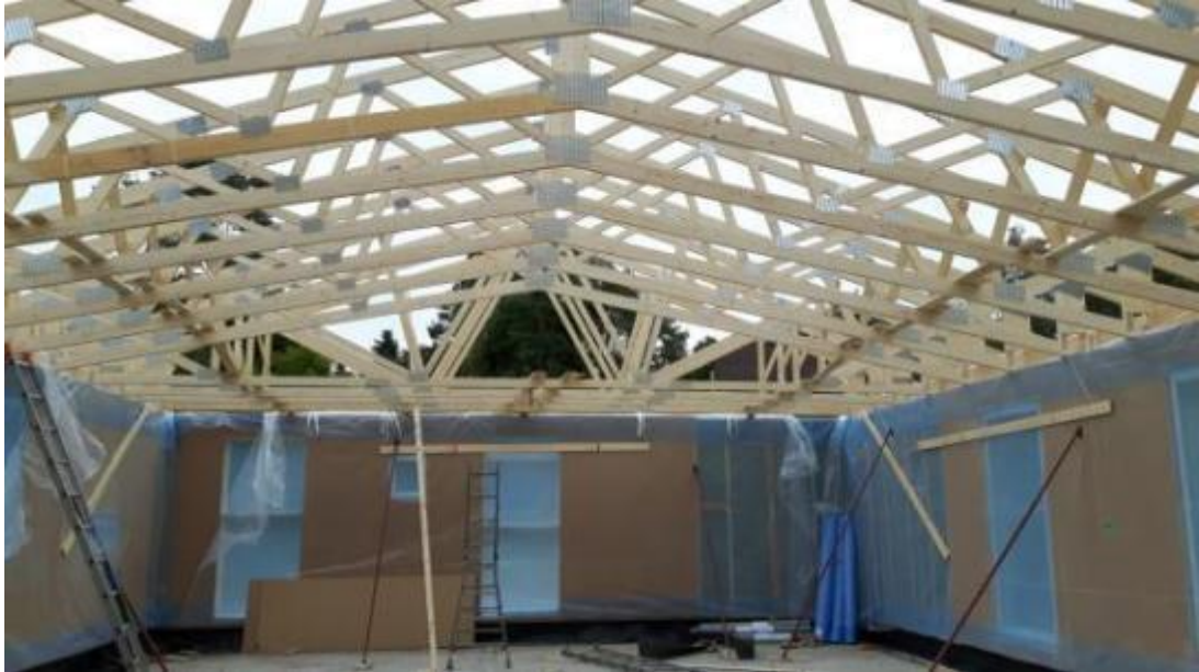
Kuva 8 Kylpyhuoneen kohdalla olevat harjaristikot ja nousevan sisäkaton osassa saksiristikot.
