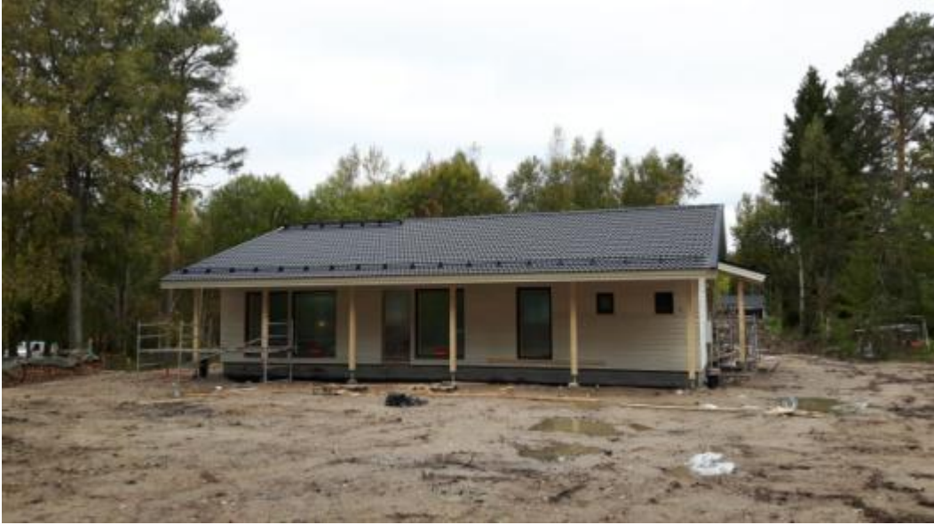
Kuva 16 Valmiin asennuksen tulos takapihalta.
