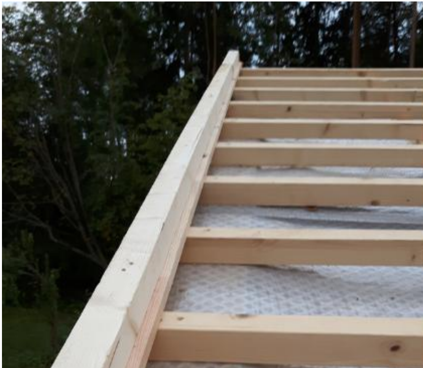
Kuva 13 Päätyräystäälle tehty rakenne, johon räystäspellit kiinnitetään.
