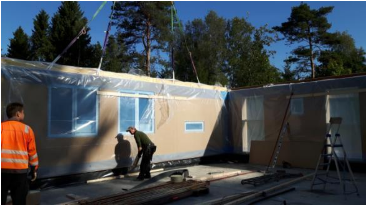
Kuva 5 Seinäelementti nostetaan yläpuussa kiinni olevista liinoista.
