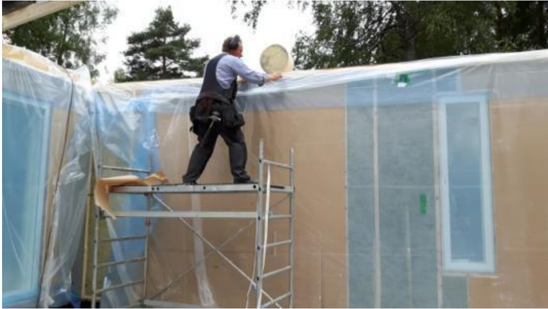
Kuva 9 Nousevan sisäkaton päädyssä seinä- ja päätyelementin saumaan asennetaan villakaista.
