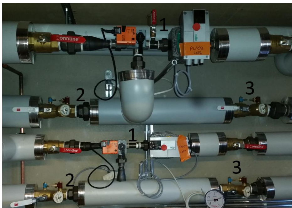
Kuva 27: Mittauspisteet lämmityspiireistä.
