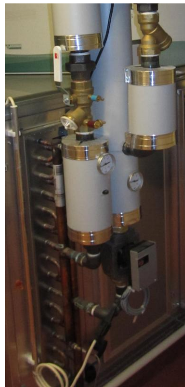
Kuva 15: Ilmastointikoneen lämmityspatteri.
