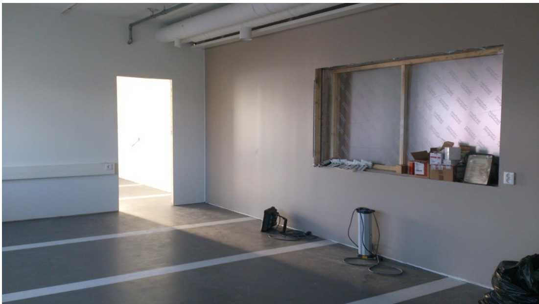
Kuva 12. Uusi taukotila sisätyövaiheessa
