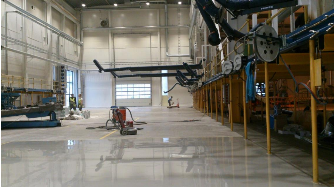
Kuva 18. Hitsaamon A-halli lattian pinnoitusta vaille kunnossa
