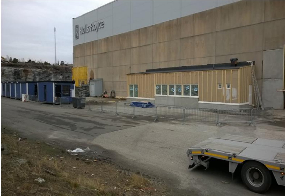
Kuva 11. Uusi taukotila ennen julkisivutöitä.
