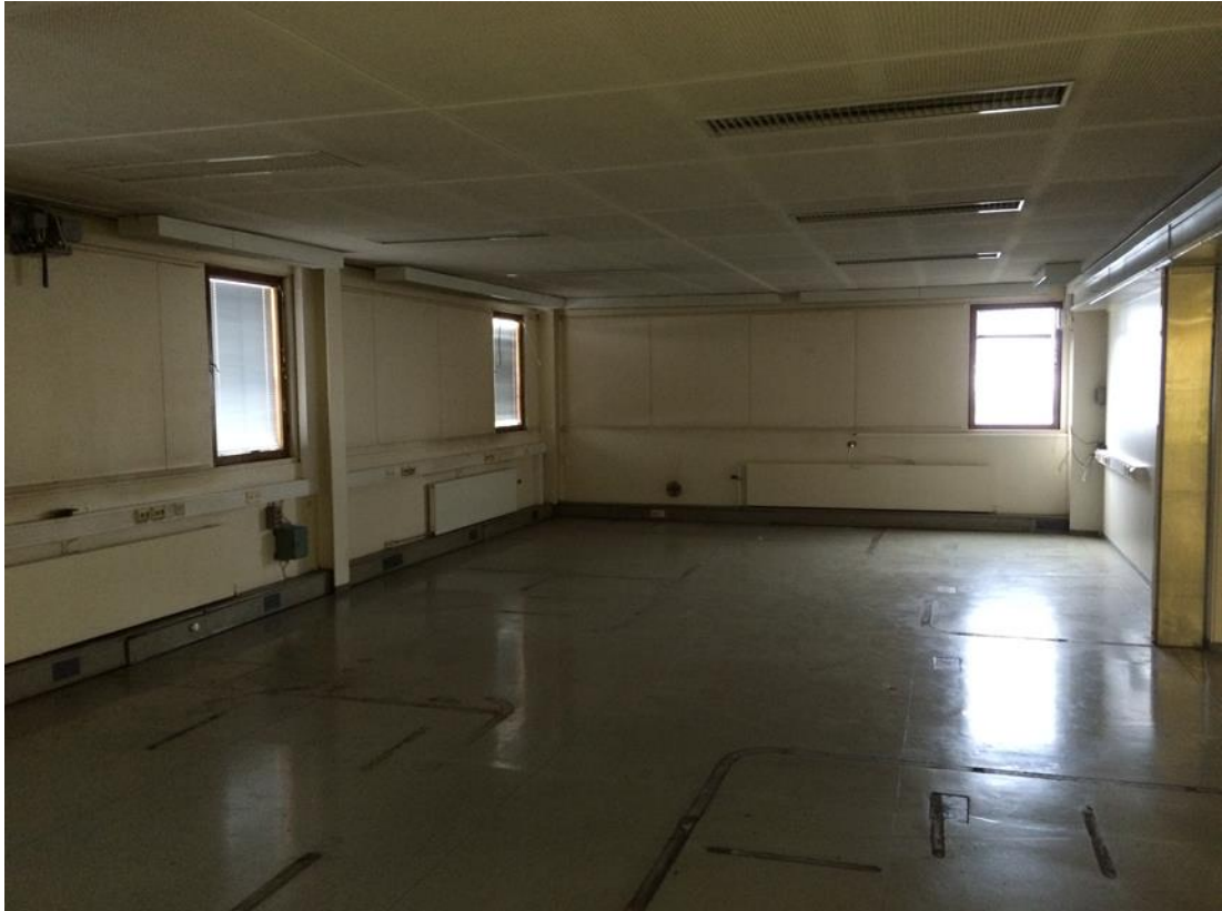
Kuva 15. Vanha taukotila ennen purkutöitä.
