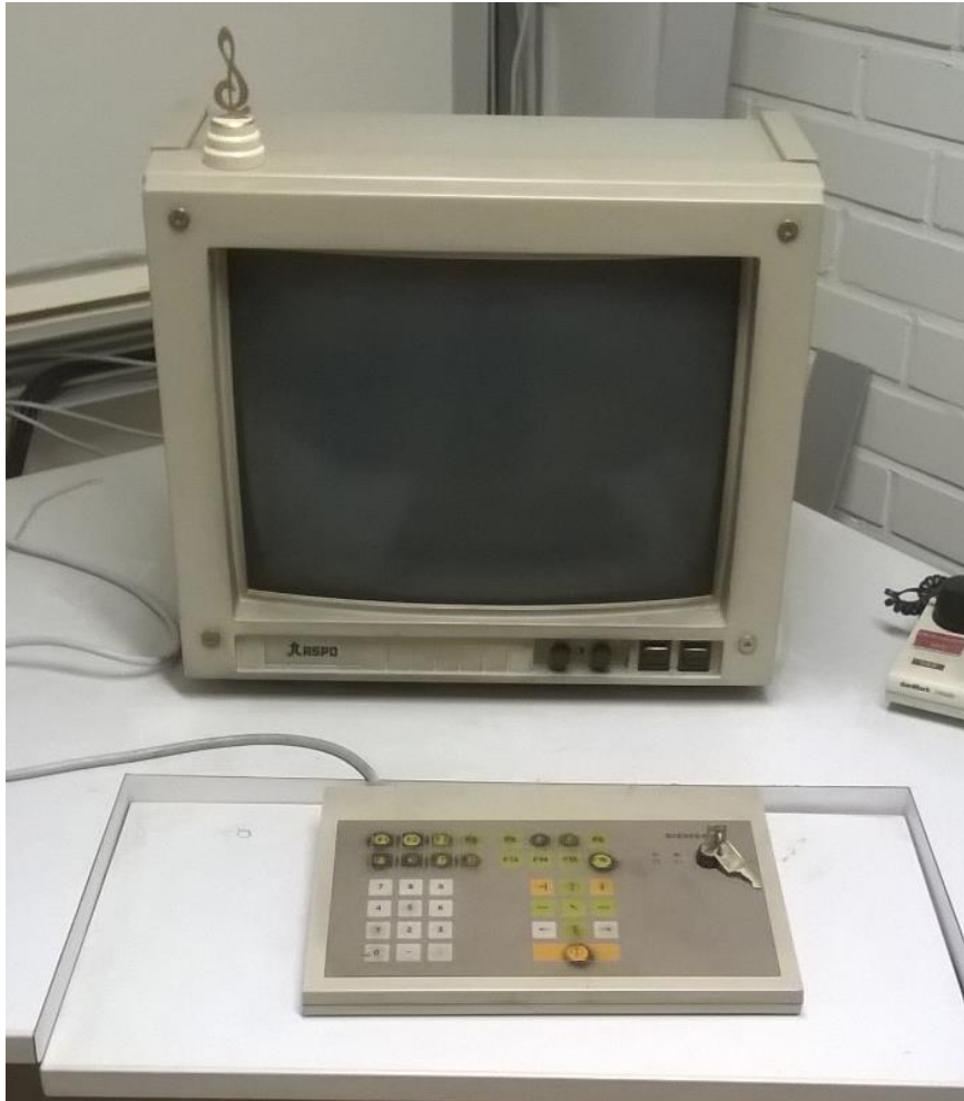
Kuvio 4. Kaukolämpökeskuksen nykyinen paikallisvalvomo
