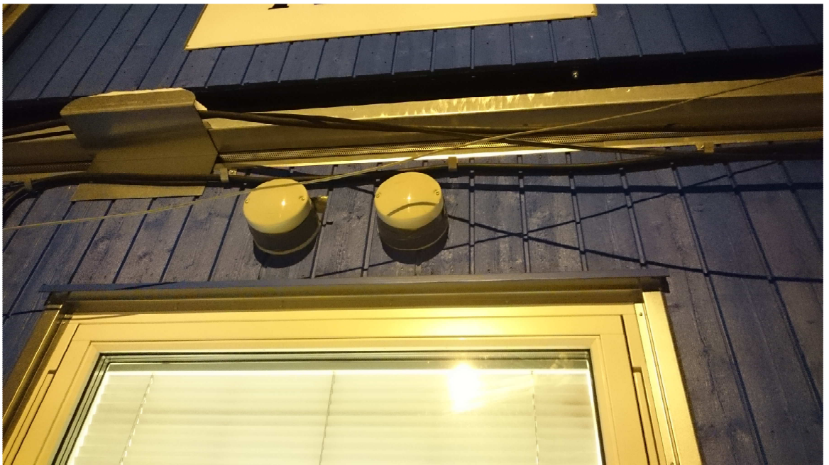
Kuva 4. kanavien teippaus ulkoapäin
