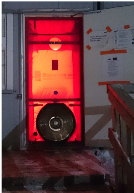
Kuva 2. Ovipuhallin on asennettuna
