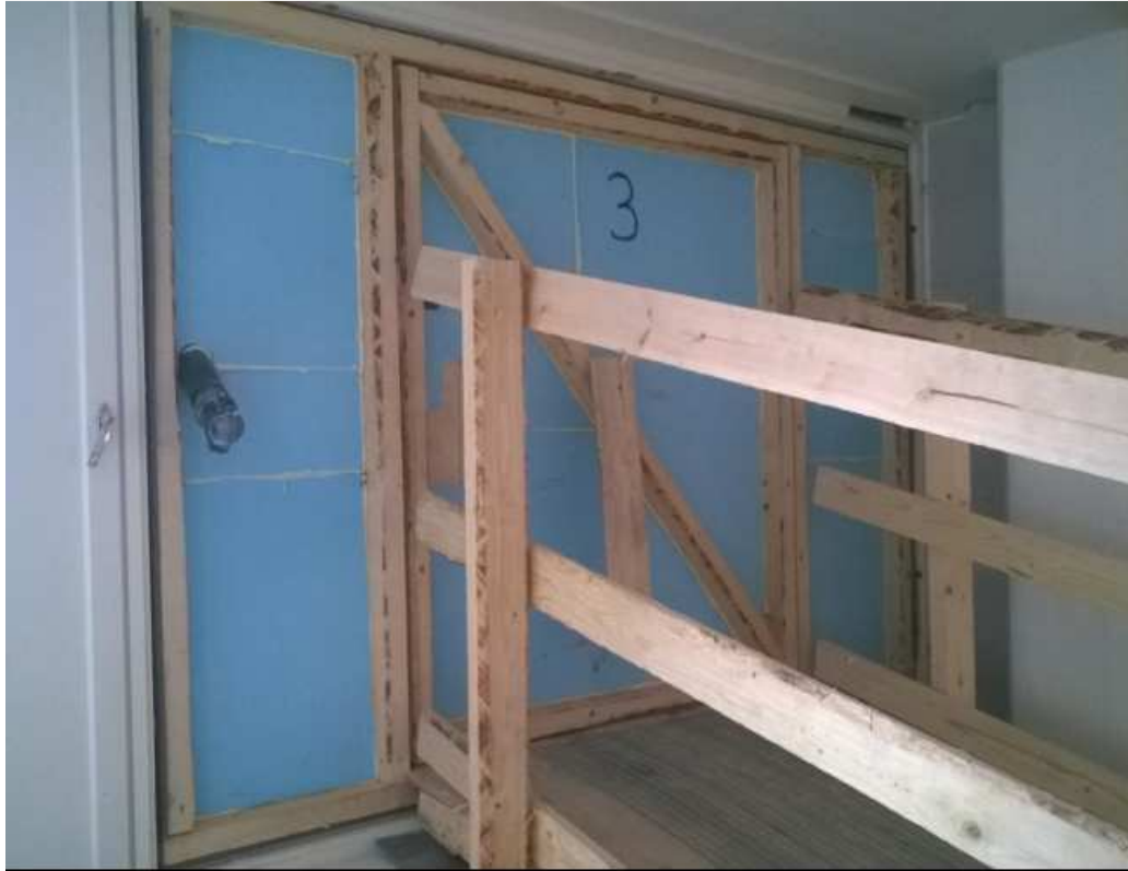
Kuva 4. Työmaan väliaikainen kulkuovi
