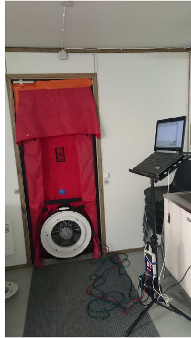
Kuva 2. Ovipuhallin on asennettuna
