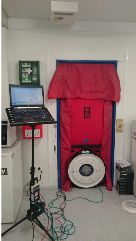
Kuva 2. Ovipuhallin on asennettuna
