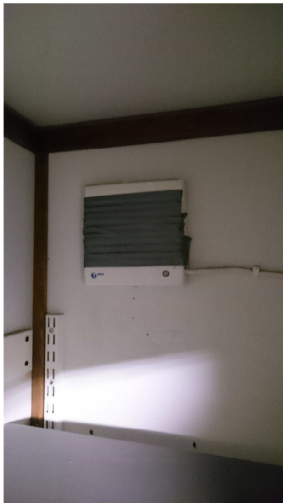
Kuva 4. Koneellinen poistokanava on teipattuna
