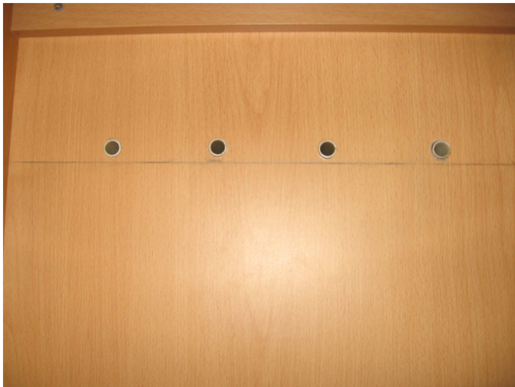
Kuva 4.3. Keittiökaapistoon porattuihin 18 mm:n reikiin asennetut muoviset sähköputket asennusvalmiina mitta-antureita varten.
