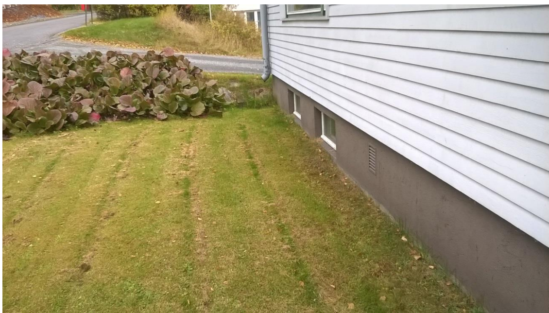
Kuva 6. Seinänvarsi kadun puolella. Kuva Jussi Väänänen 2015
