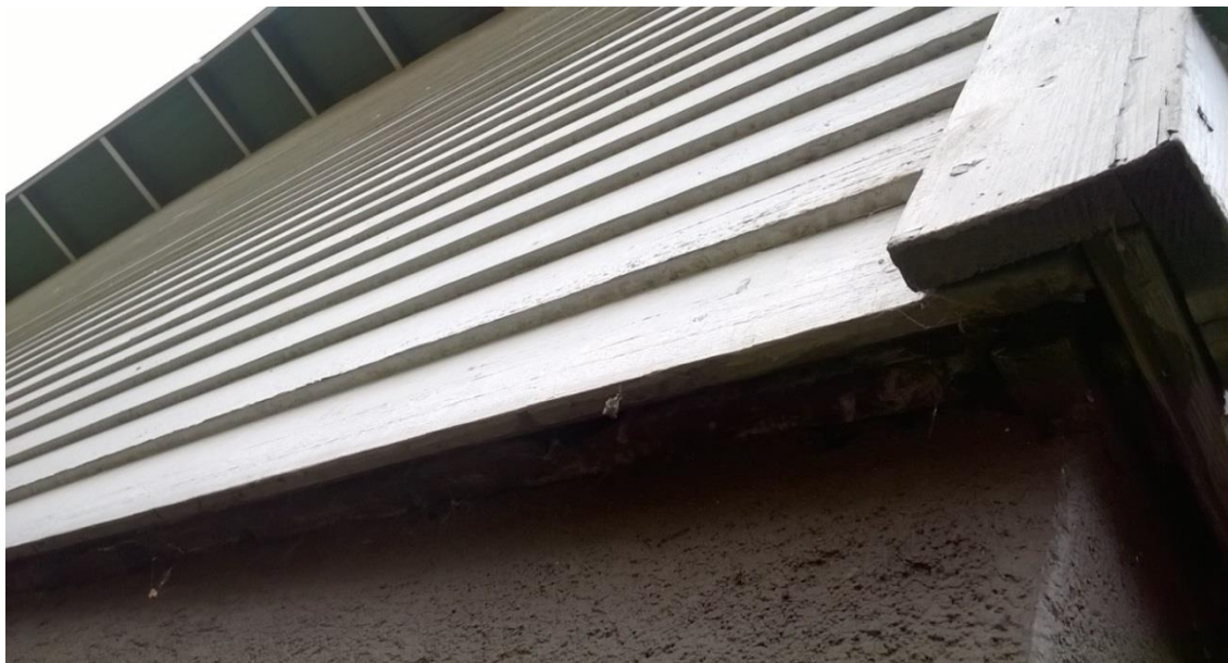
Kuva 8. Ulkoverhous ja 5 mm:n tuuletusrako. Kuva Jussi Väänänen 2015
