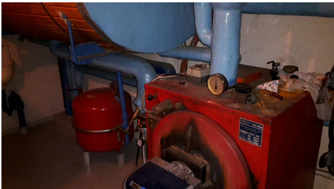
Kuva 9. Kattilahuone. Kuva Jussi Väänänen 2015
