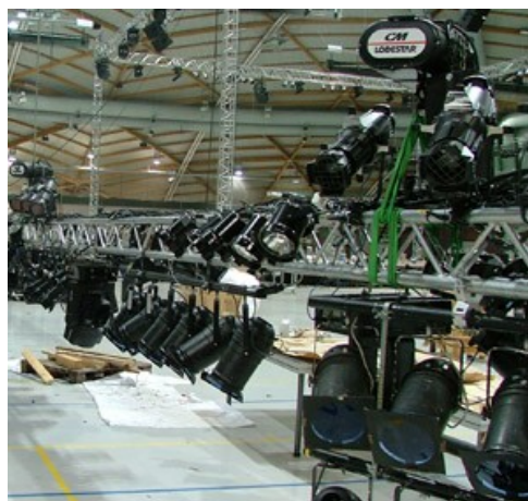
Kuva 4: Laitteiden kiinnitys trussin ala- ja yläputkiin. Kuva: Dan Vainikainen
