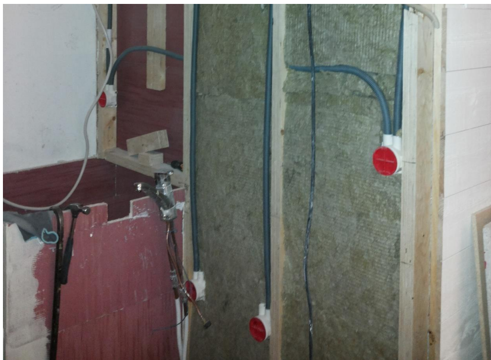
Kuva 8. Keittiön putkitus sekä pyykinpesukoneen paikka.
