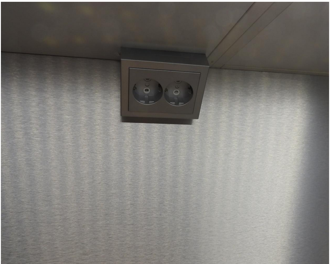
Kuva 10. Keittiön välitilan pistorasia.
