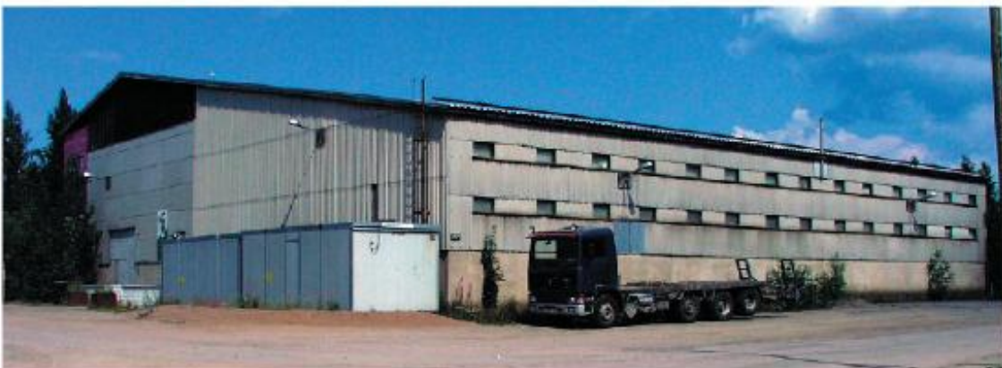
Tampellan alueen varastohalli, rakennus nro M10 etelänsivu, RAVA 2006
