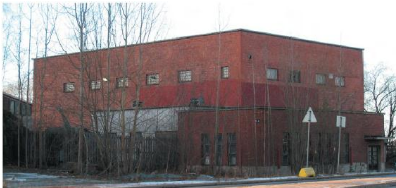
Varastorakennus nro H 12, IL 2008
