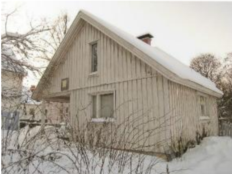
Kuva 16 Piharakennus, jonka materiaaleista 95 % on kierrätettyä.
