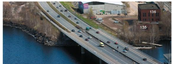
Ranta-lämpöalan alueen rakennuskanta, kuva RAVA 2004
