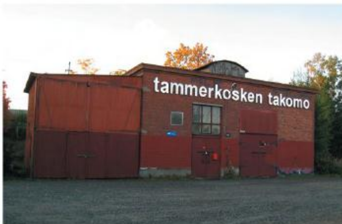
Rakennus nro 135, julkisivu pohjoiseen, II. 2008
