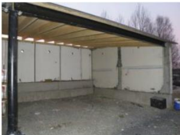
Kuva 15 Autokatos, jossa takaseinä koostuu parvekepieliementeistä ja päädyt umpinaisista kantavista päätyelementistä. (Huuhka, 2010)
