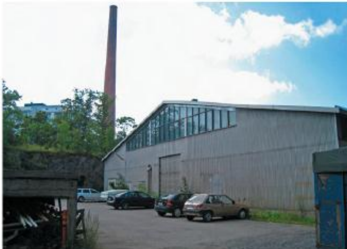
Tampellan alueen varastohallin, nro H19 itäjulkisivu, IL 2009
