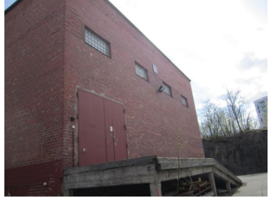
Kuva 6 Pumppaamo ja vedenpuhdistamo
