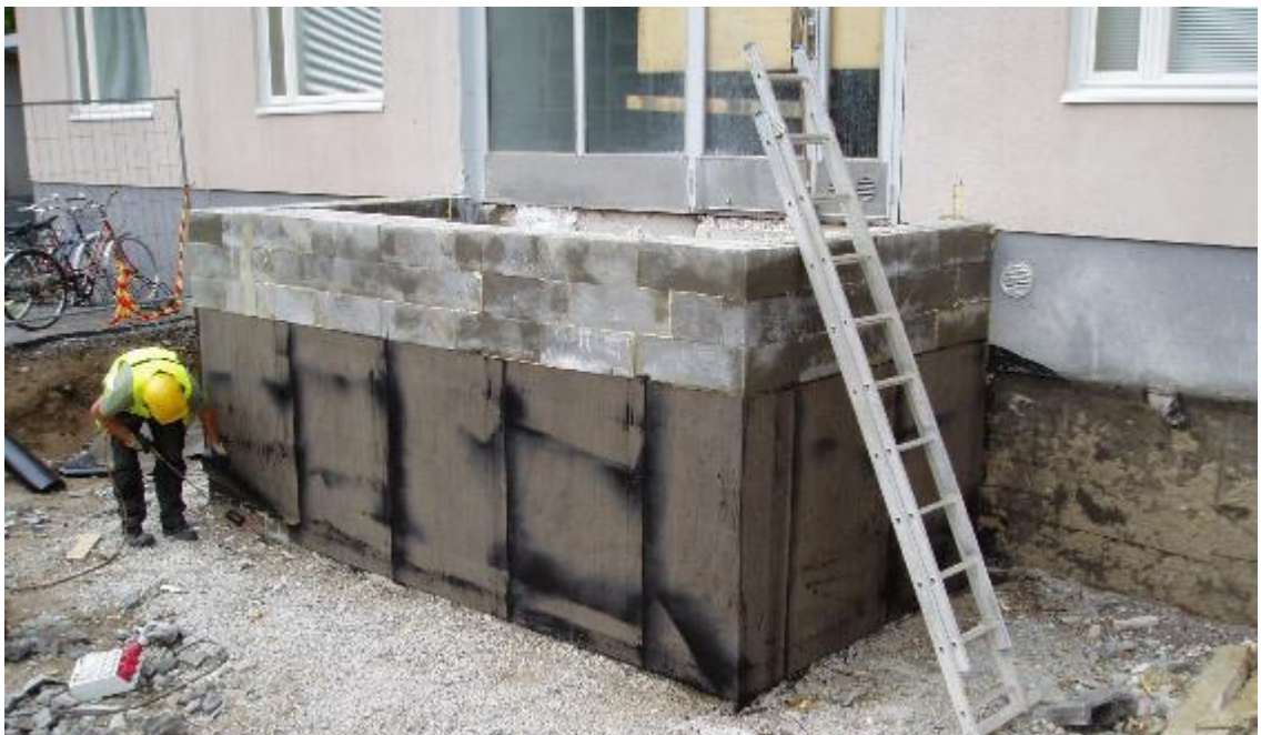
KUVA 10. Bitumihuovalla tehtävä vedeneristystyö on käynnissä
