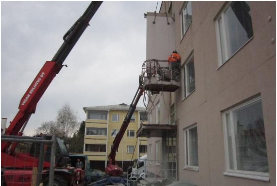
KUVA 5. C-portaan tuuletusparvekkeet ovat purkuvaiheessa
