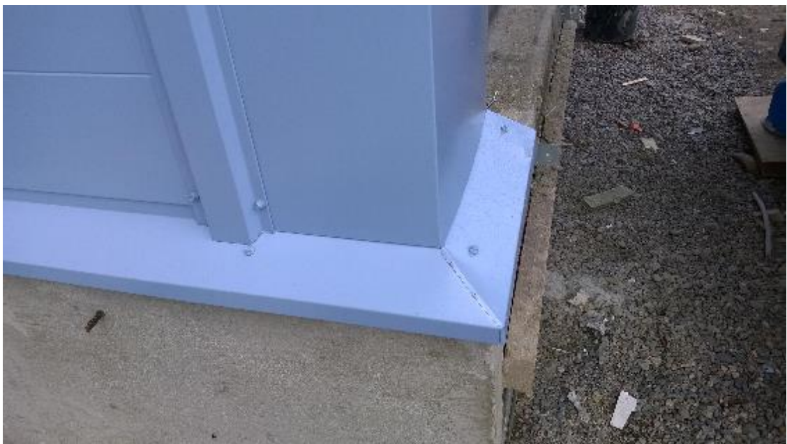
KUVA 16. Hissikuilun ulkopuolista viimeistelyä
