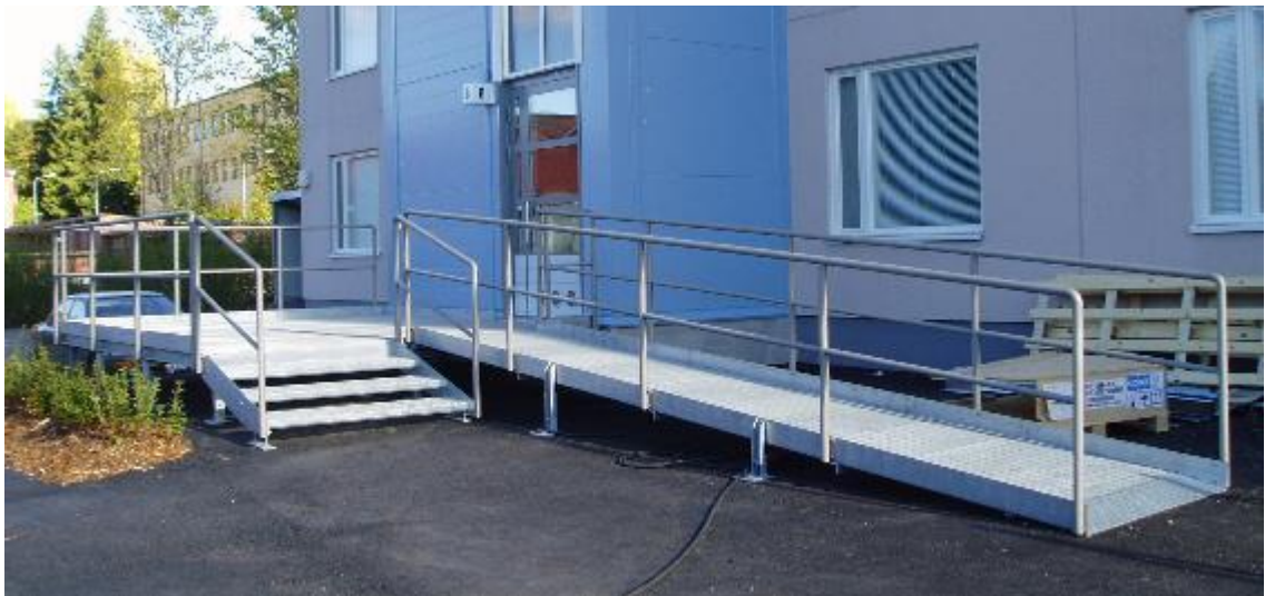
KUVA 25. Valmis pyörätuoliluiska ja portaat ulko-ovelle (Kuva, Heimo Ovaska 2015)
