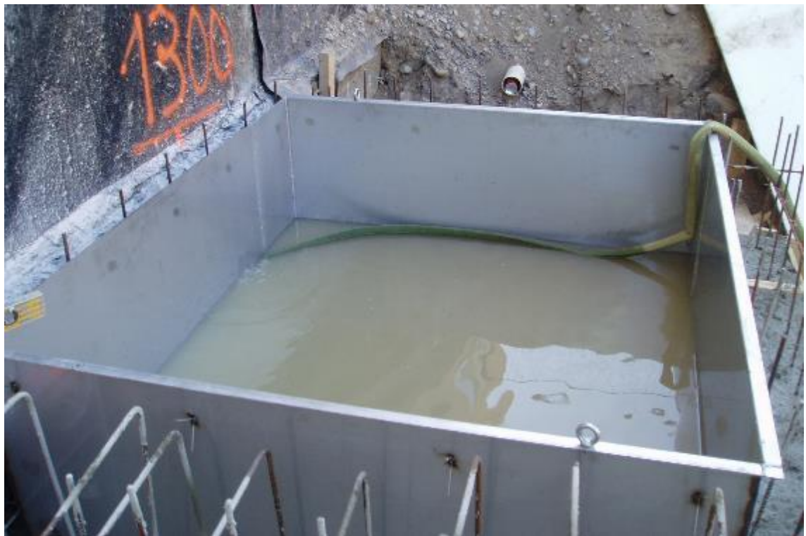
KUVA 7. RST allas tulevassa perustuksissa
