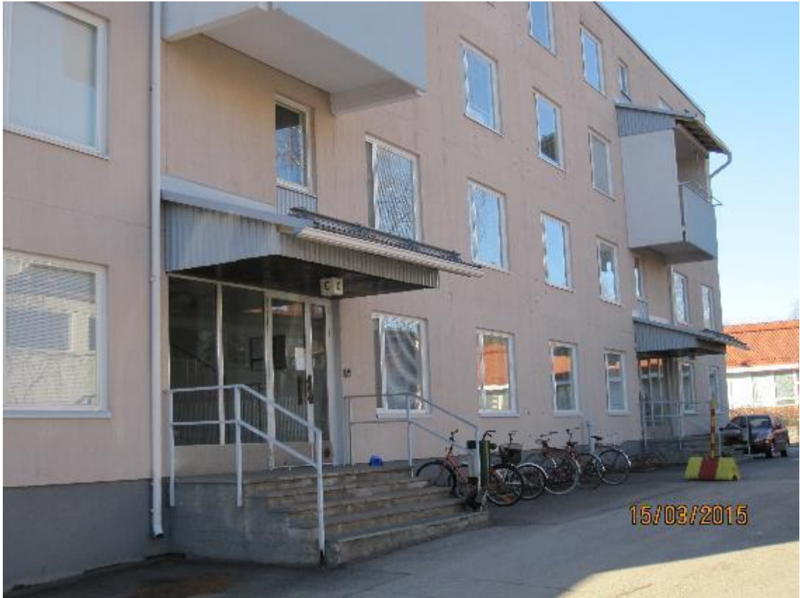
KUVA 1. Talon julkisivua ennen peruskorjausta (Kuva, Heimo Ovaska 2015).
