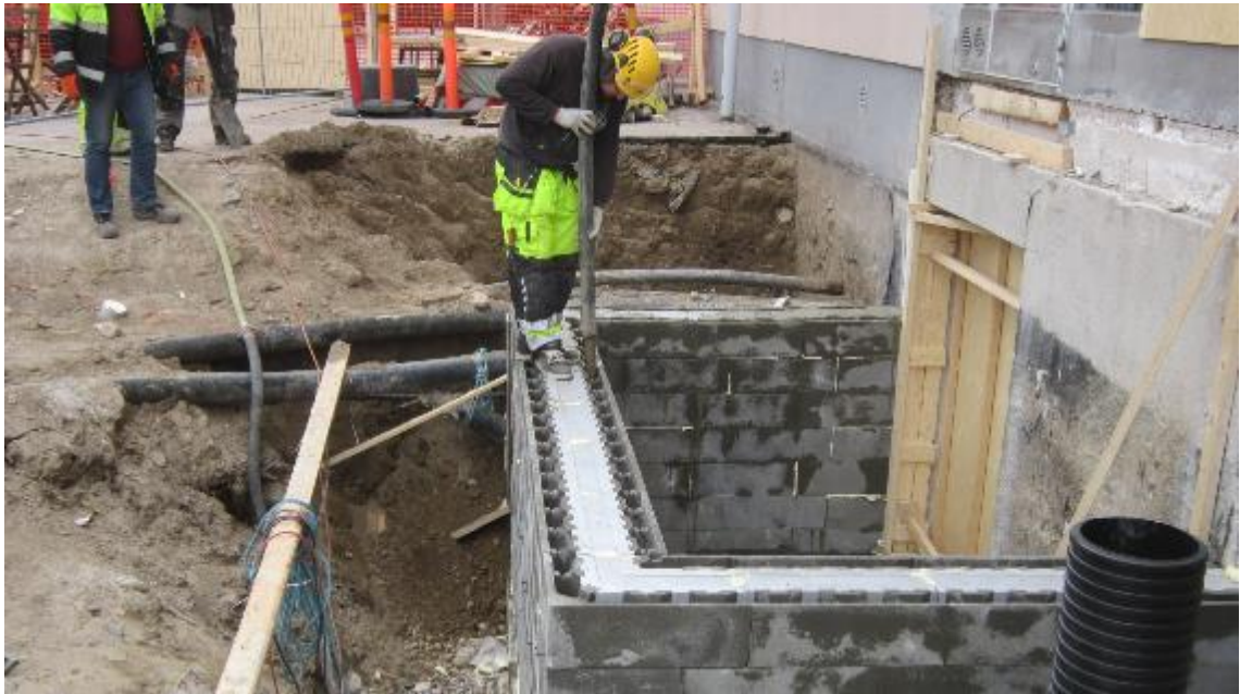
KUVA 9. Perustuksen lämpökivien täyttövalu työnalla
