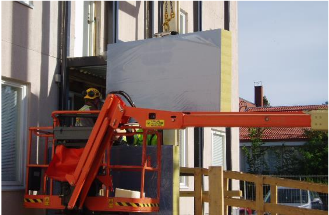
KUVA 15. PVP – elementin asennus käynnissä
