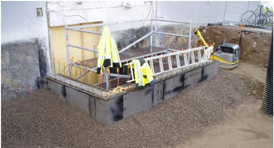
KUVA 11. Ympäristön täyttö soralla ja tiivistys
