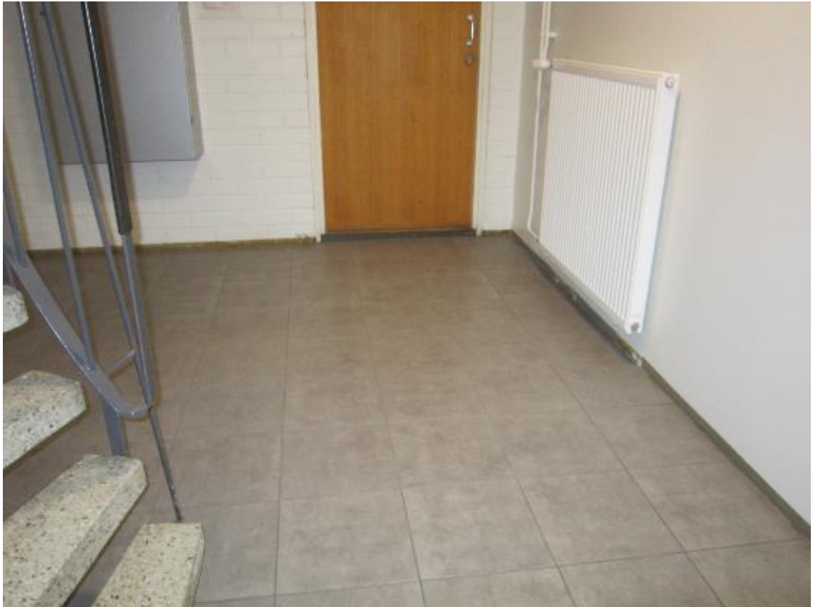
KUVA 21. Kuvassa on uusittu kellarikerroksen lattia ja vesipatteri
