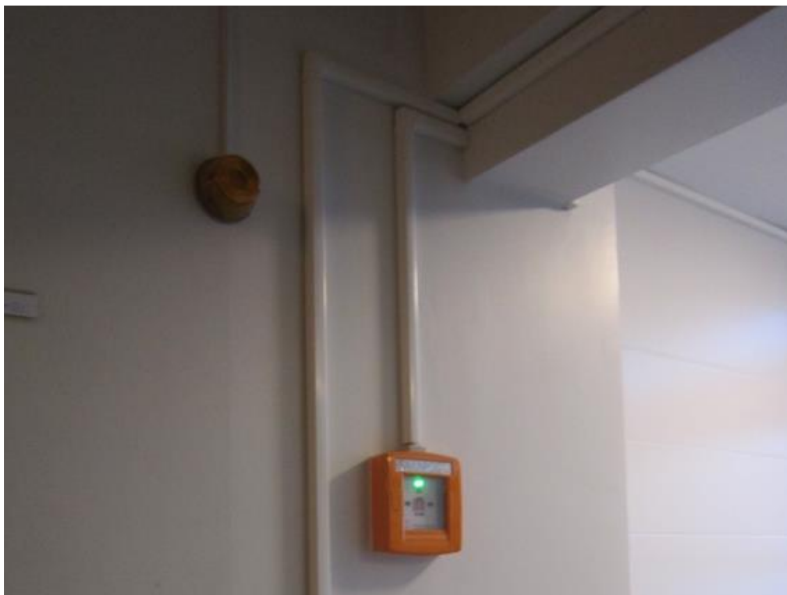
KUVA 22. Uusien sähköjen asennus vaatii pinta-asennuksia porraskäytäviin
