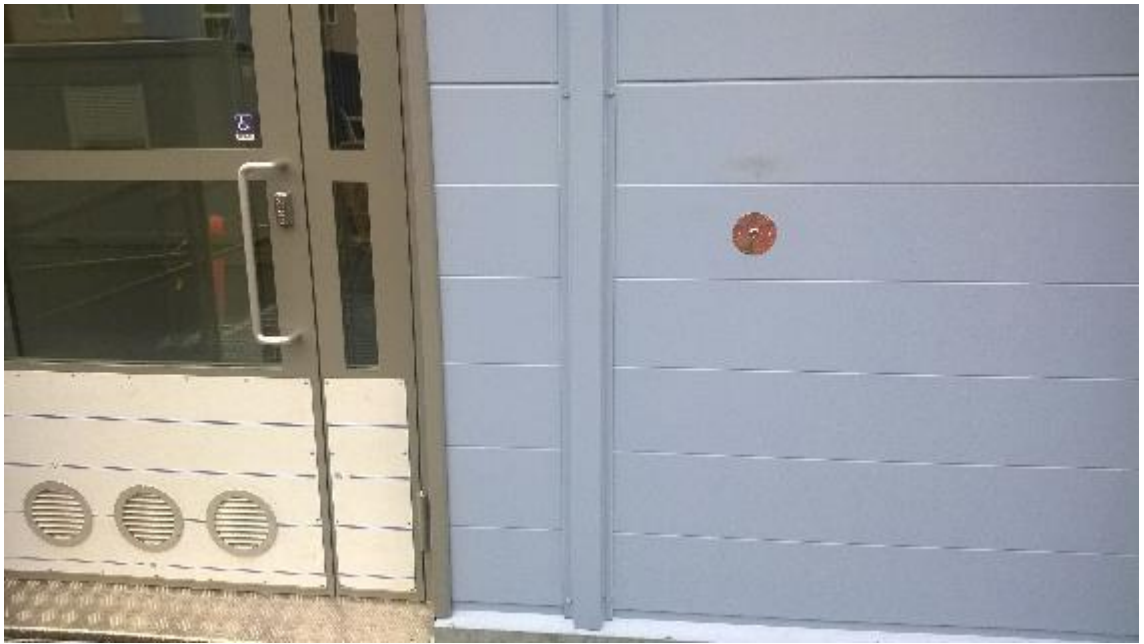
KUVA 26. Ylimääräinen lukko seinällä on pyörätuolin käyttäjille
