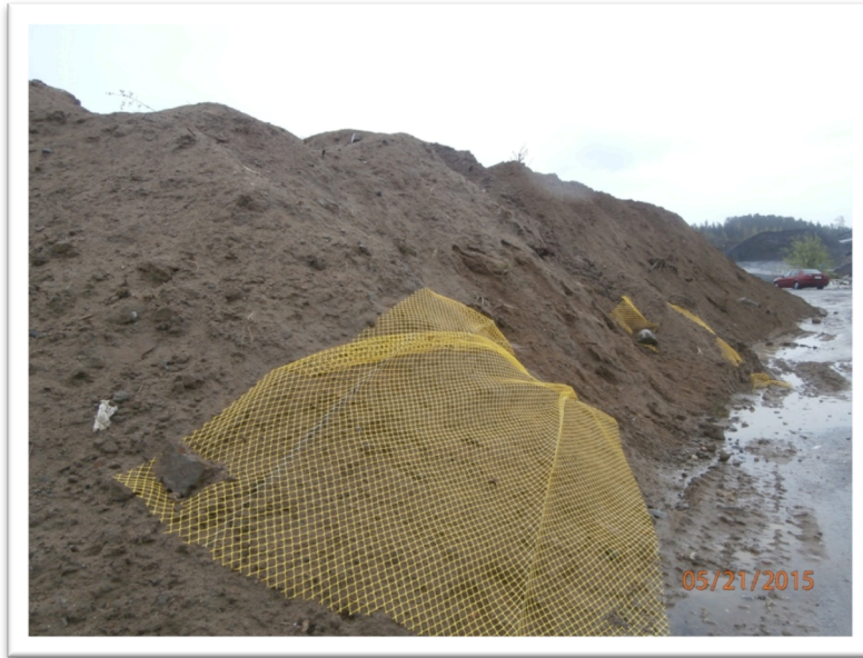
KUVA 3. Puhdistettavat maamassat on jaoteltu kolmeen kasaan, ja kasat on eroteltu toisistaan keltaisella huomioverkolla (kuvan omistaja: Maarit Luoranen)
