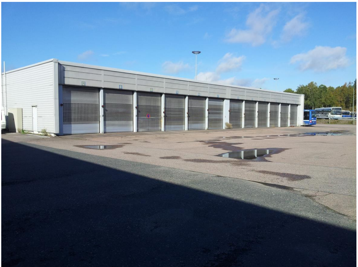
Kuva 19. Vartiokylän uudet varastotilat ulkoapäin.
