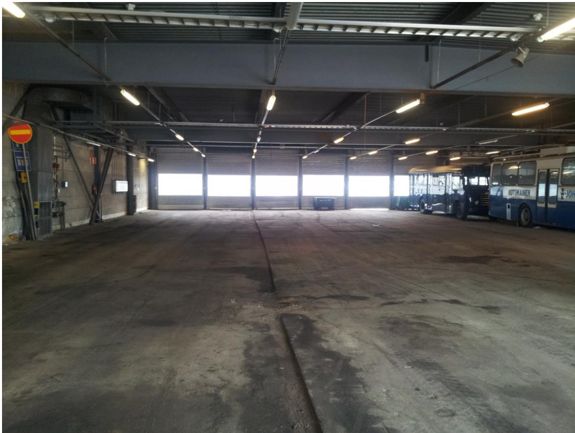
Kuva 20. Vartiokylän varastotilat ennen varastohyllyjen asentamista.
