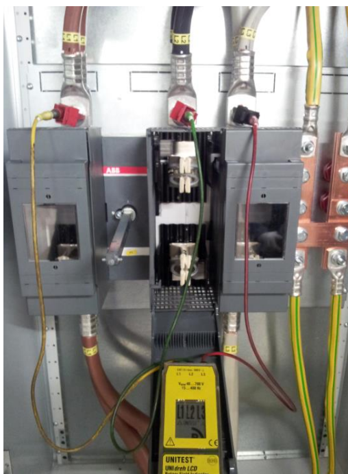
Kuva 42. Kentän kiertosuunnan ja vaiheistuksen mittaus.
