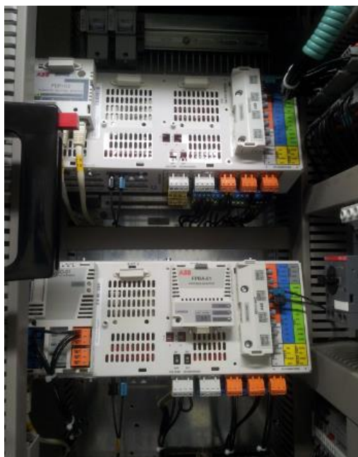
Kuva 37. Taajuusmuuttajan ohjausyksiköt.
