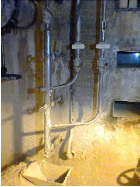
KUVA 4. Esiselkeytsaltaan patjanmittausputkisto
