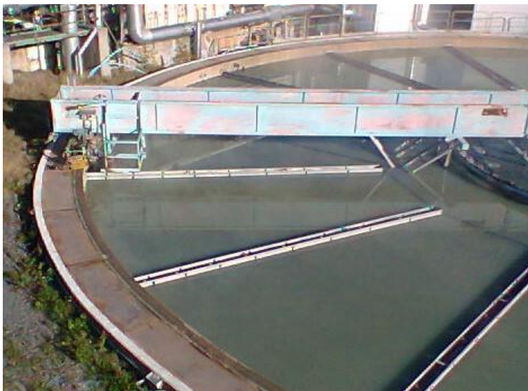
KUVA 2. Esiselkeytysaltaan silta
