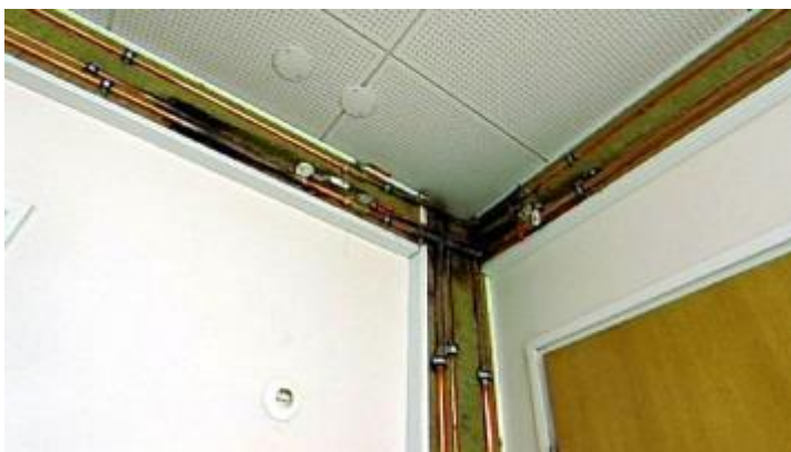
Kuva 18. Avoinna oleva elementti porraskäytävässä (asuntotieto.com)
