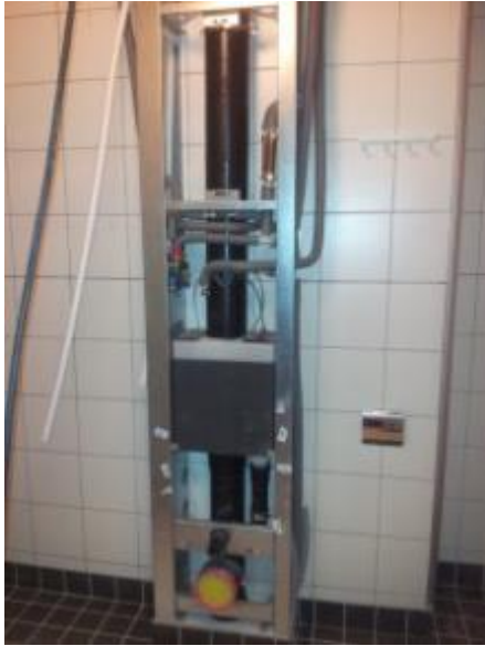
Kuva 9. Putkielementti, johon kiinnitetään wc-istuin (Consti Oy)
