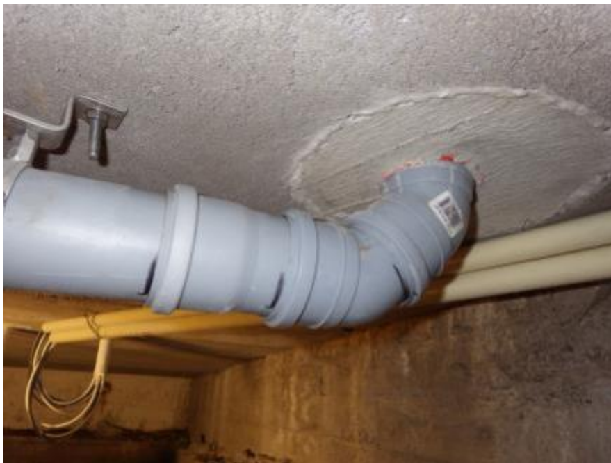
Kuva 3. Kuvassa 110 mm:n PP-viemäri. Viemäriin läpivientikohdassa näkyy punainen palokatkonauha. (Paavo Tapioharju)
