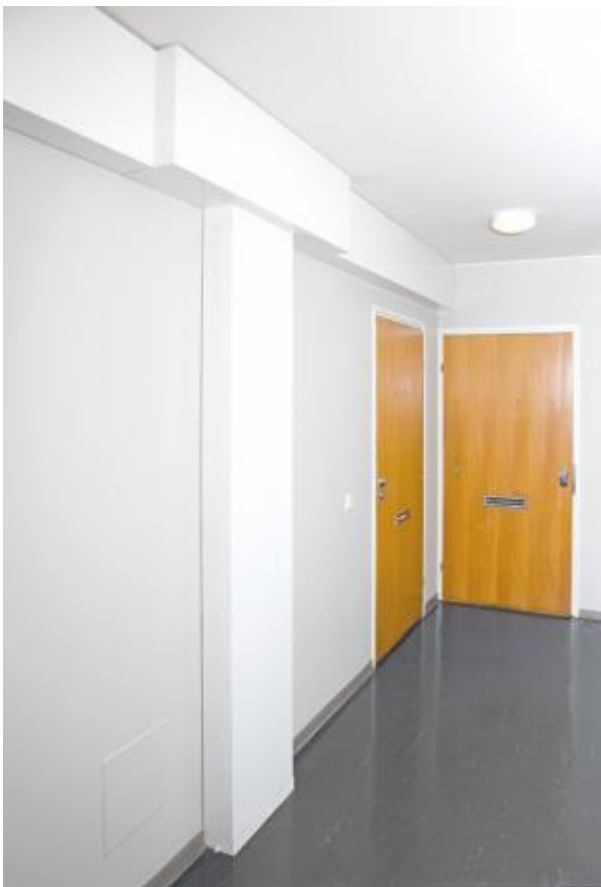
Kuva 11. Valmis Pipemodul-elementti porrashuoneessa (Pipe-Modul Oy)
