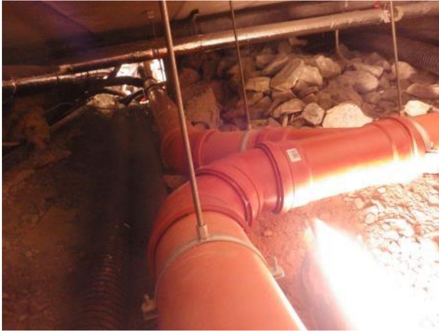
Kuva 2. Kuvassa 160 mm:n PP-viemäri. (Paavo Tapioharju)
