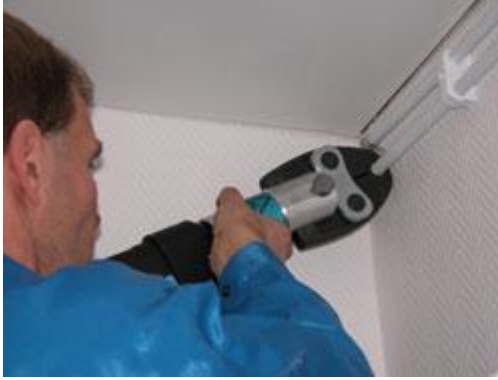
Kuva 7. Puristusliitoksen tekeminen puristuskoneella (rakentaja.fi)
