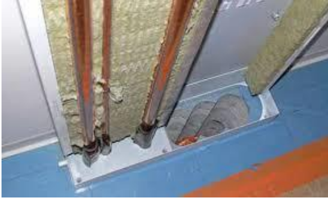
Kuva 10. Pipemodul-kotelo asennusvaiheessa (Cupori Oy)
