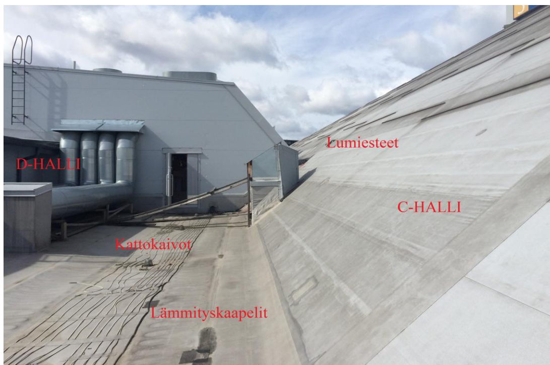
KUVA 10. C- ja D-hallien välissä oleva vesikatto
