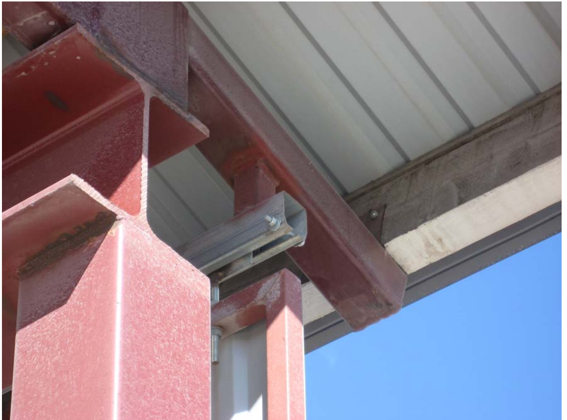
Kuva 10. Kuvassa näkyvät C-kiskon ja liukuoven kiinnitykset.
