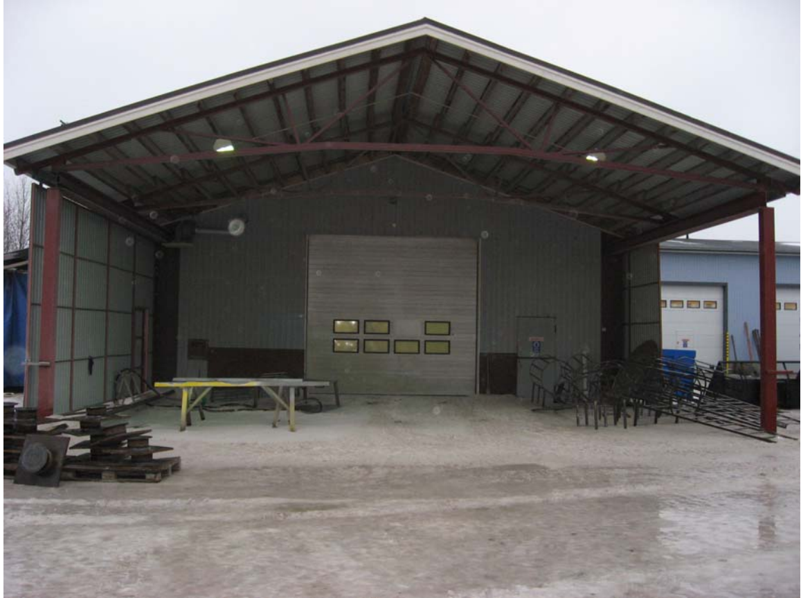
Kuva 3. Pressujenvetolaite kiinnitetään kuvassa olevan kattotuolin alaputkeen.
