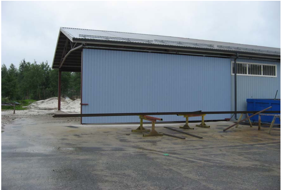
Kuva 11. Tien puoleinen liukuovi paikoilleen asennettuna.
