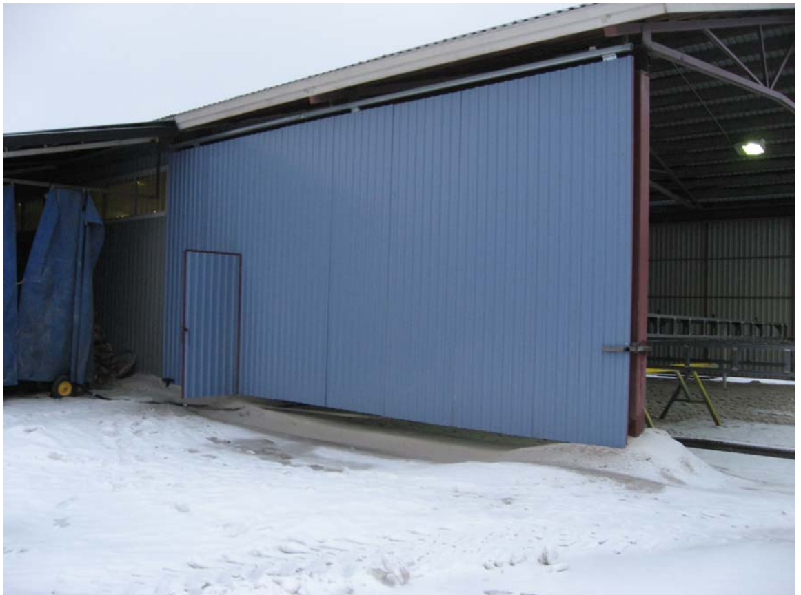
Kuva 15. Liukuovi paikoilleen asennettuna
