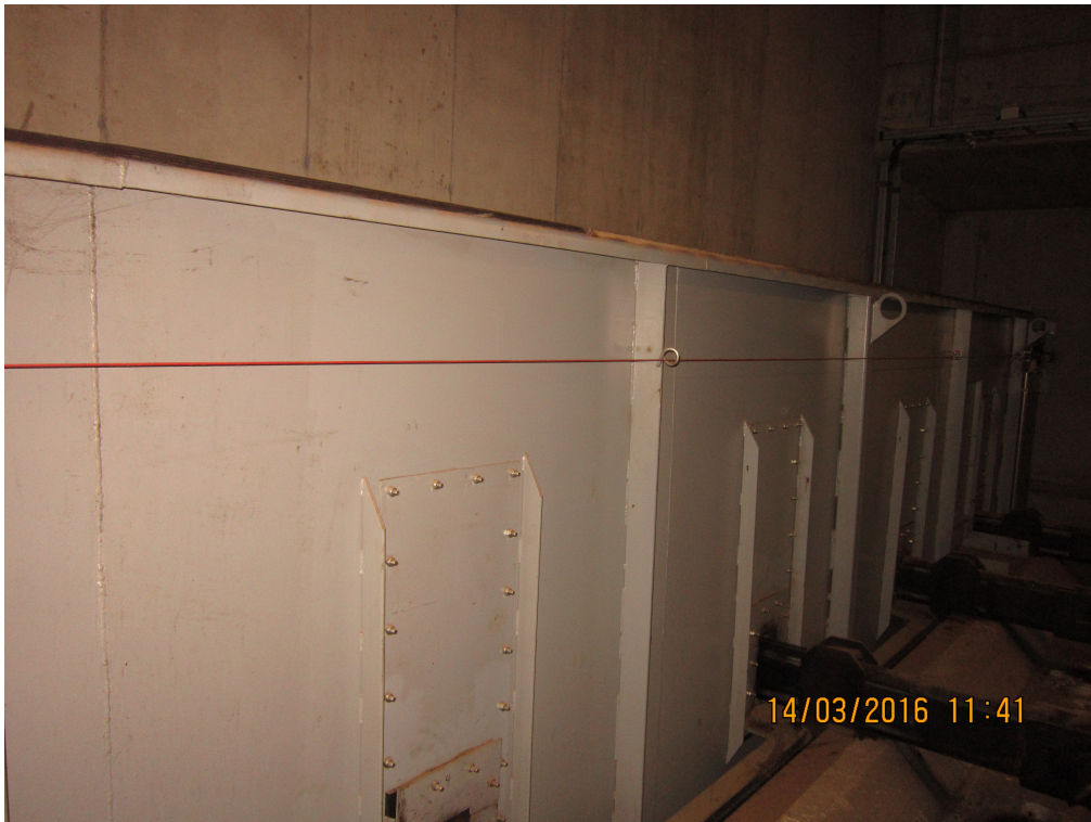
Kuva 2. Katetut kuljettimet Karpalokaaren lämpölaitoksella (Kuva: Krista Haataja).
