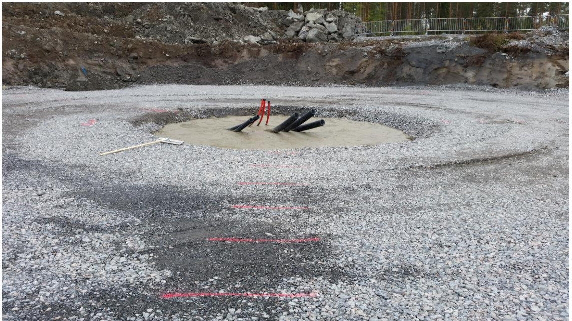
KUVA 8. Työbetonilaatta oikeassa korossa.
