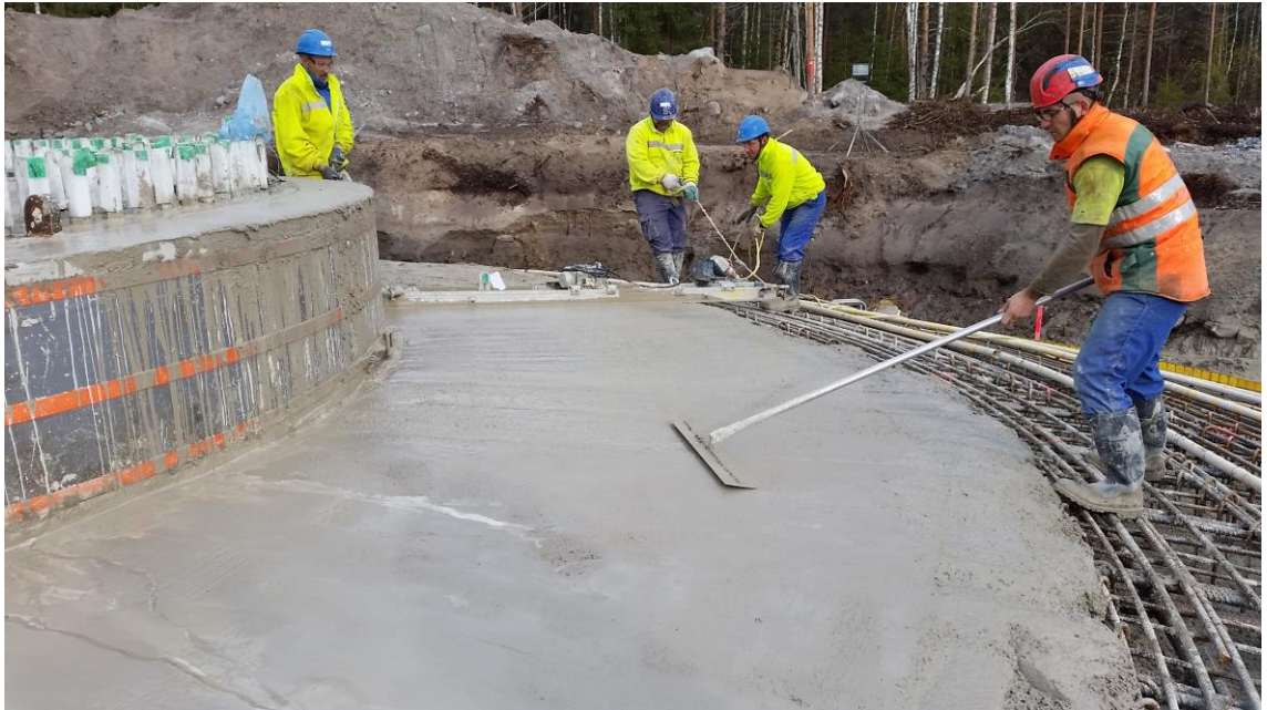
KUVA 12. Betonipinnan hiertoa
