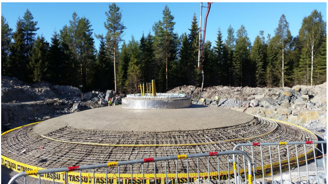
KUVA 13. Perustuksen pinnan tekoa
