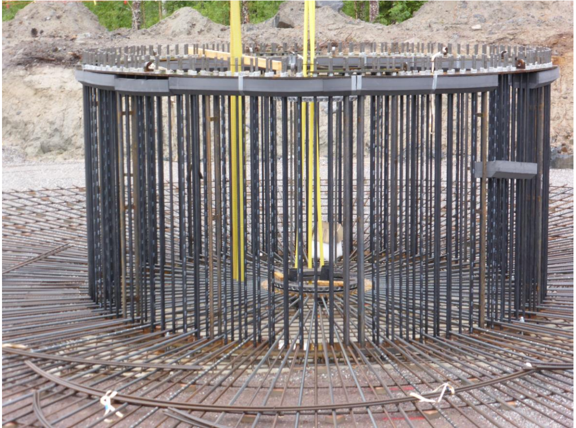
KUVA 9. Valmis pulttikehä paikalleen asennettuna.
